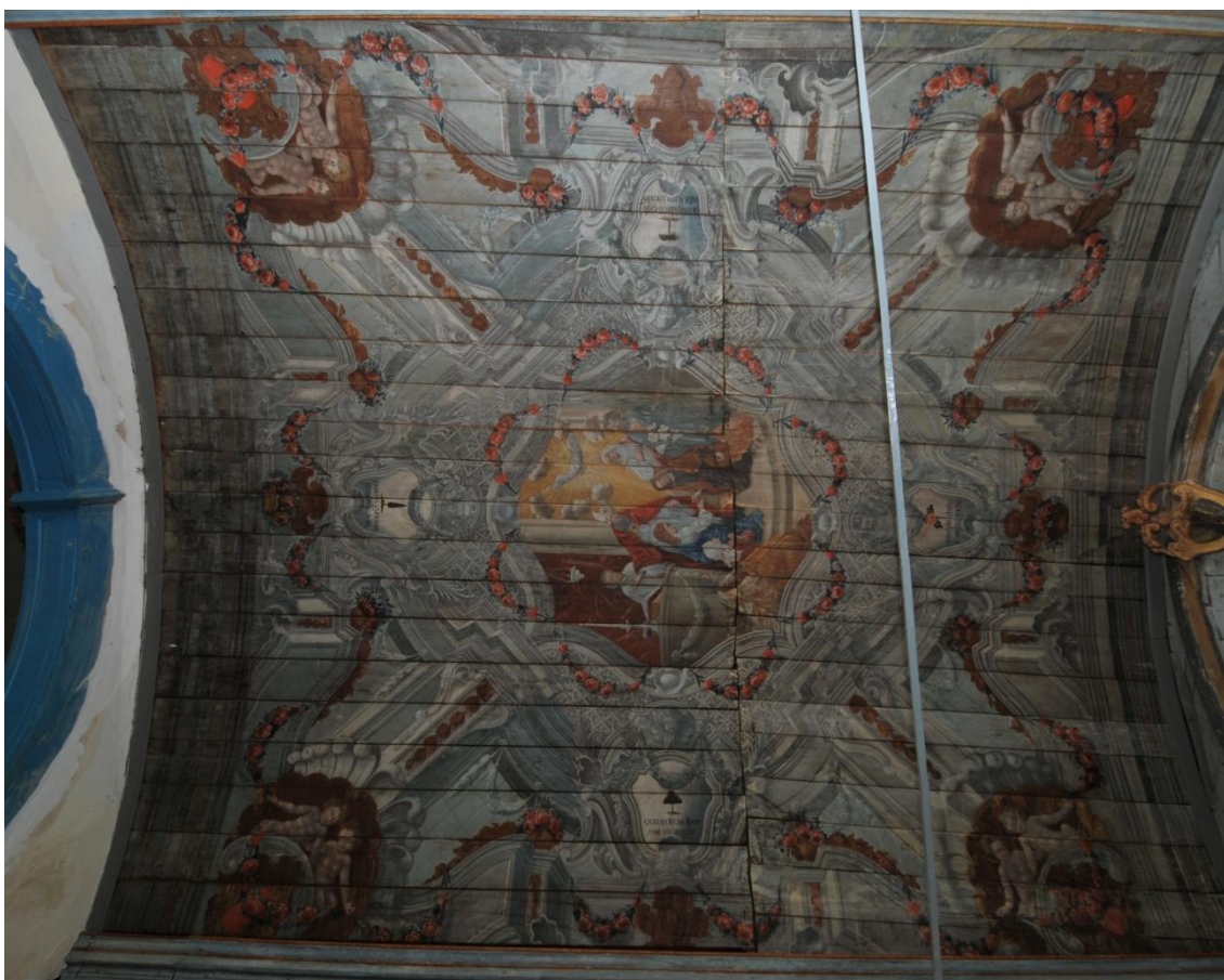
Figura nº 52: Capela-mor de Santana do Inhaí. Foto: Eduardo Orlando
