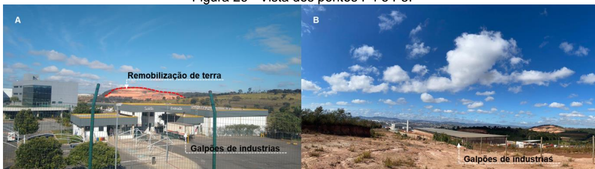
Figura 26 - Vista dos pontos P4 e P5.
