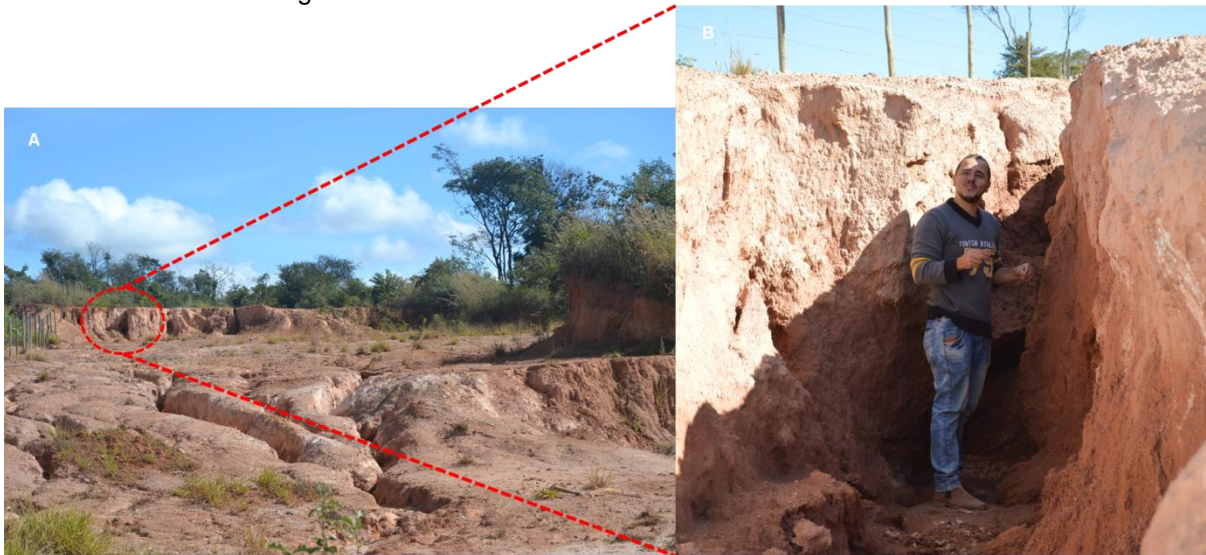
(A) Vista geral do Ponto P5 em que são observados processos erosivos iniciais; (B) altura e profundidade do processo erosivo iniciado na área.
