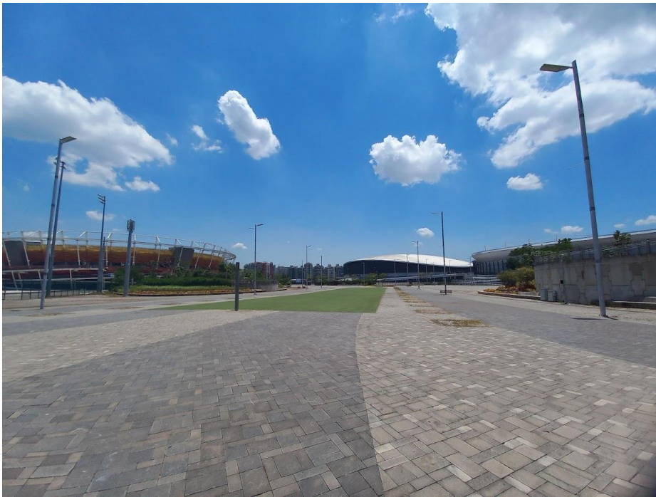
Figura 17 – Complexo de Tênis (à esquerda) e Velódromo e Arenas Carioca (à direita) e Rua Olímpica (ao centro)
