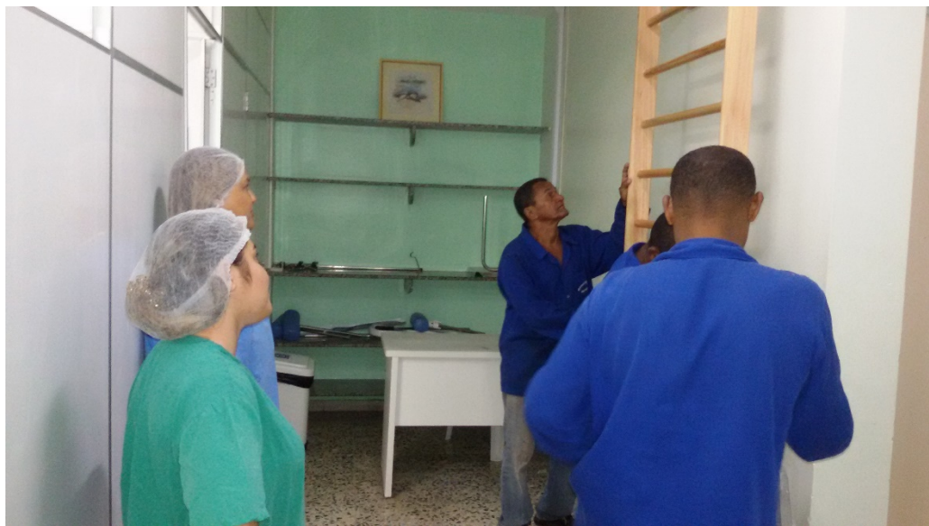
Figura 1 – Centro de Parto quando da chegada da escada de Ling
