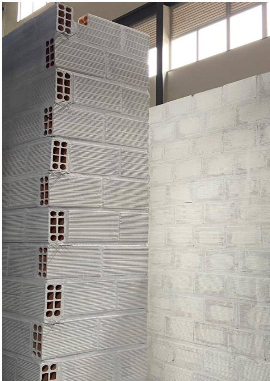
Figura 78 – Vista lateral da primeira alvenaria tipo ALV - 4
