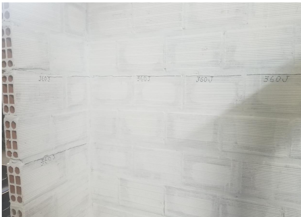
Figura 88 – Vista posterior com as fissuras após o impacto de 360 J
