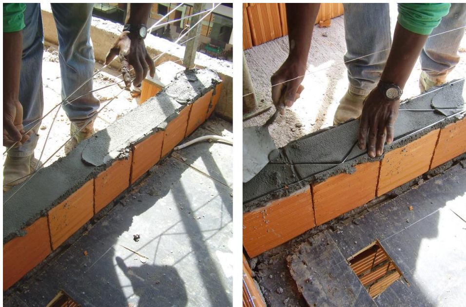
Figura 23 – Aplicação da treliça plana aramada com argamassa convencional
