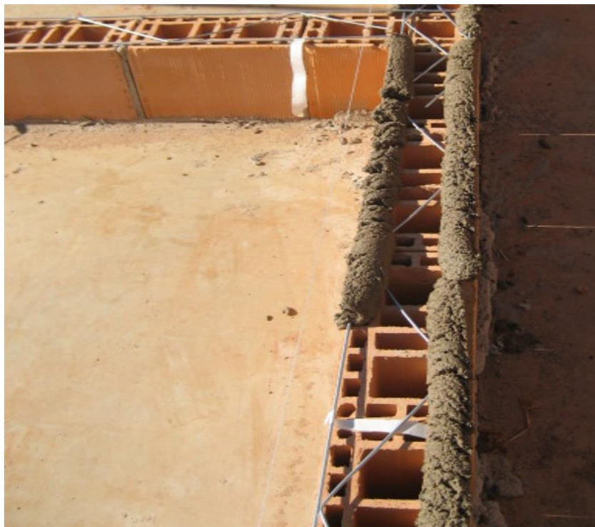
Figura 24 – Aplicação da treliça plana aramada com uso de cordões de argamassa convencional ao longo das paredes laterais de blocos cerâmicos vazados
