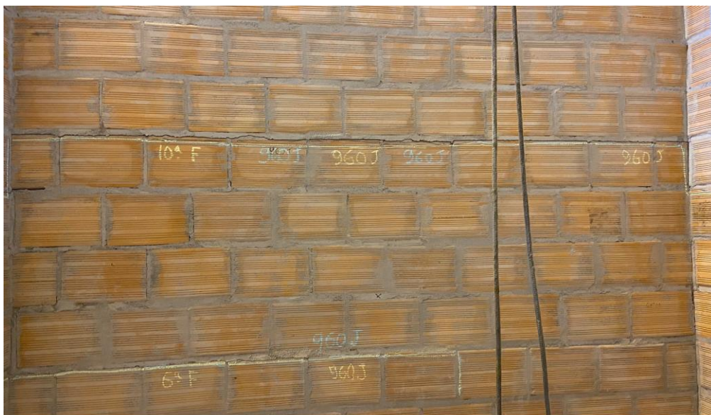
Figura 72 – Vista frontal da segunda alvenaria tipo ALV - 3
