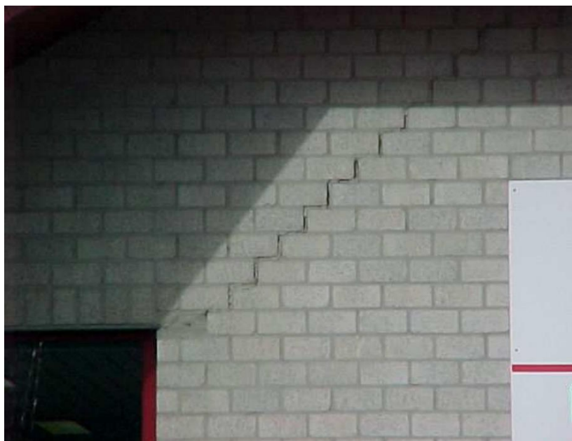
Figura 28 – Manifestação patológica ocasionada por concentração de tensões
