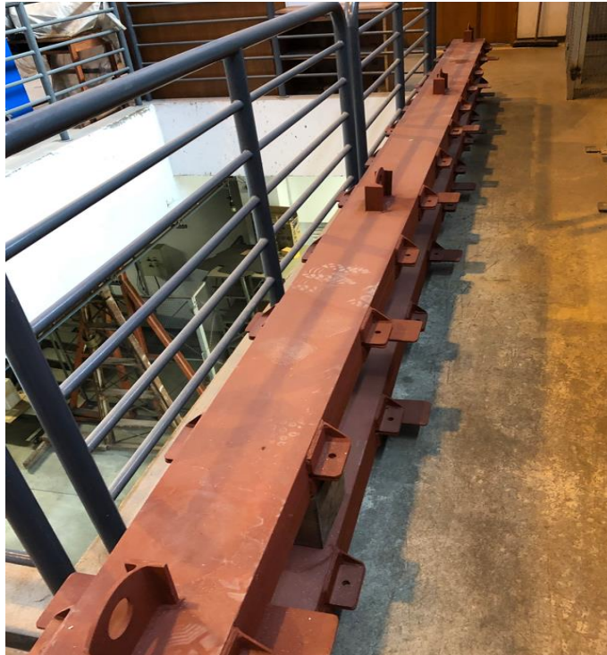
Figura 43 – Apoios para as alvenarias em aço
