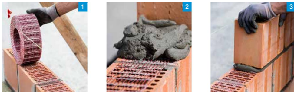
Figura 11 – Aplicação do rolo compacto em obra
