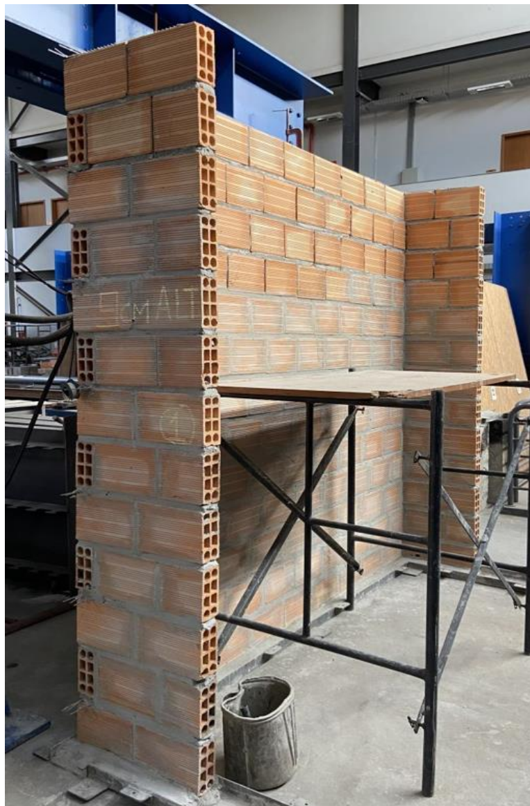
Figura 40 – Alvenaria tipo ALV - 4 sendo moldada com o auxílio de andaimes
