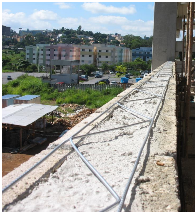
Figura 8 – Ilustração da treliça plana aramada galvanizada
