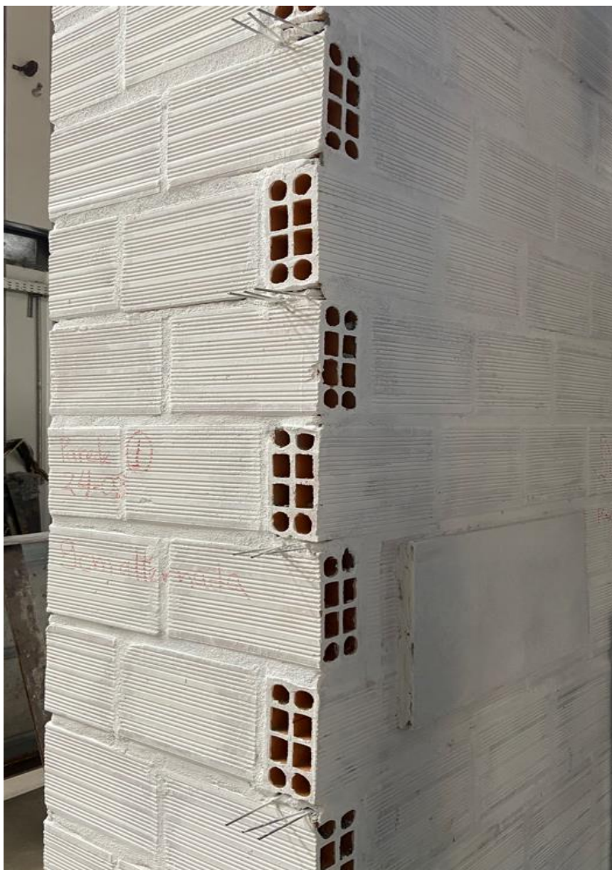
Figura 79 – Vista lateral ampliada da primeira alvenaria tipo ALV - 4
