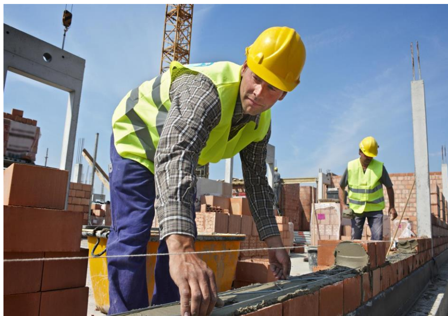
Figura 9 – Aplicação de treliça plana aramada galvanizada em obra
