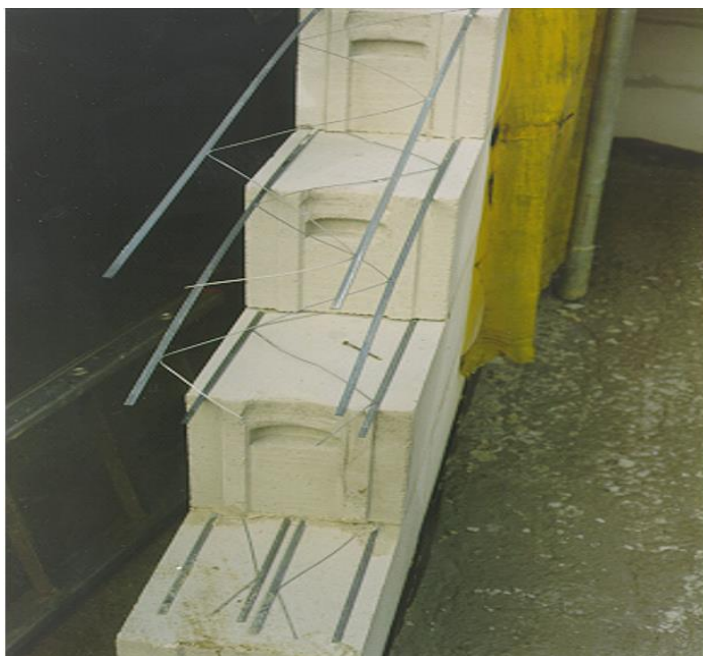
Figura 20 – Detalhe da treliça plana aramada tipo Flat , de fios longitudinais achatados
