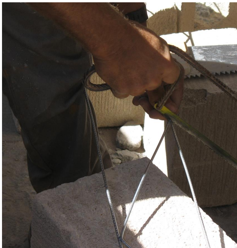
Figura 18 – Em detalhe, a treliça plana aramada
