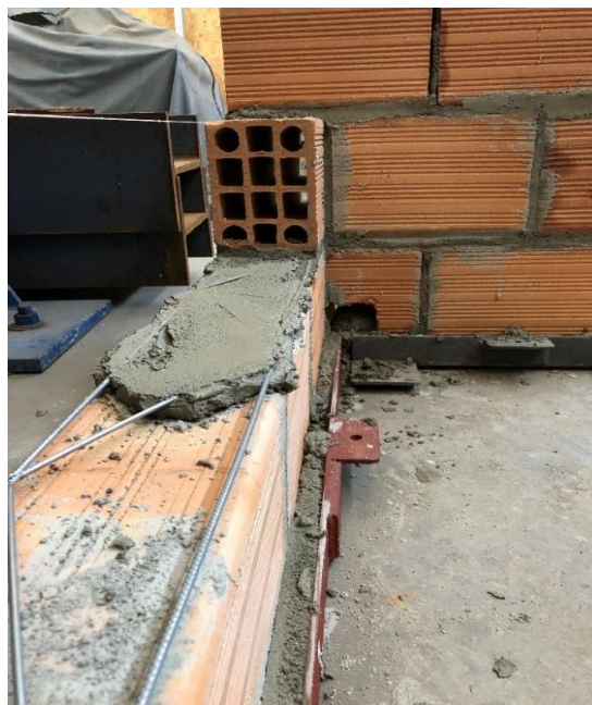
Figura 38 – Colocação da treliça plana aramada
