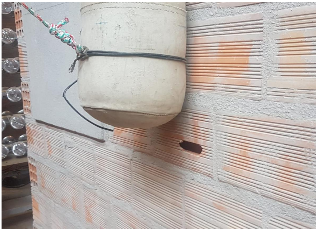
Figura 64 – Ruptura localizada no bloco após impacto de 720 J
