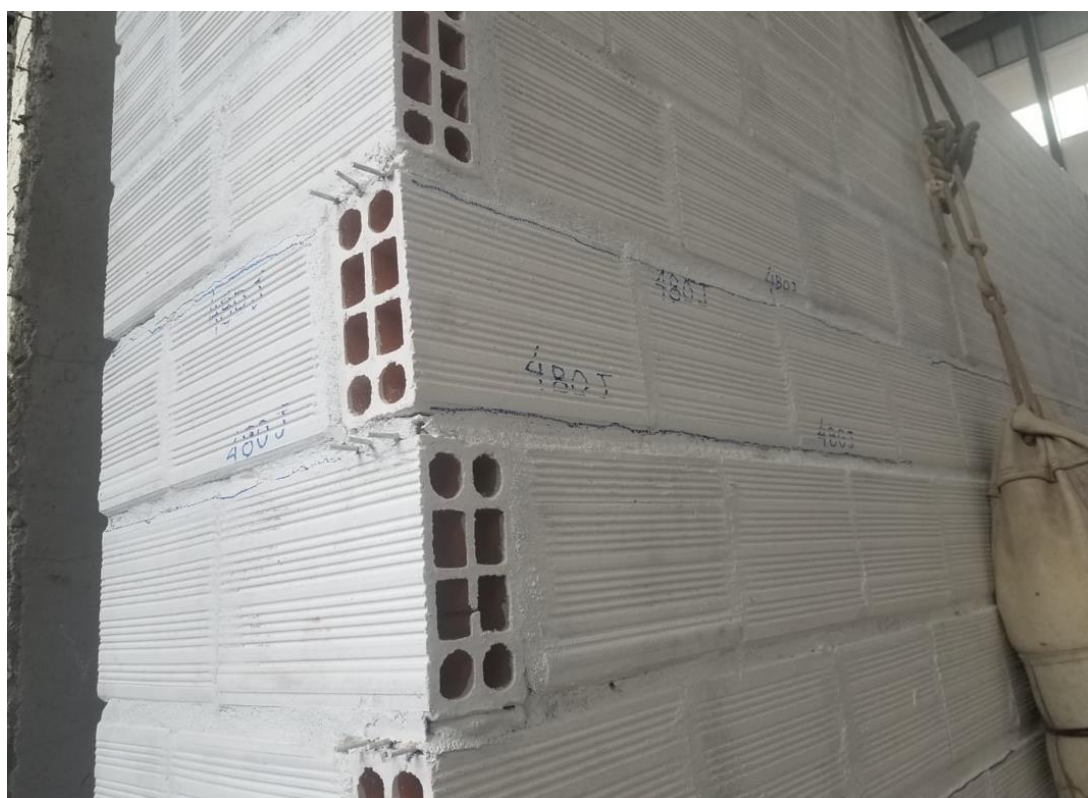
Figura 106 – Fissuras no lado frontal da alvenaria após o impacto de 480 J
