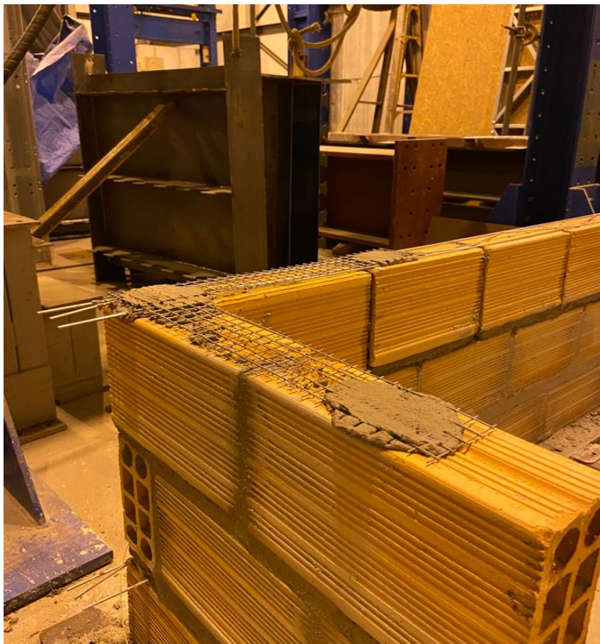
Figura 41 – Amarração com auxílio de telas eletrossoldadas
