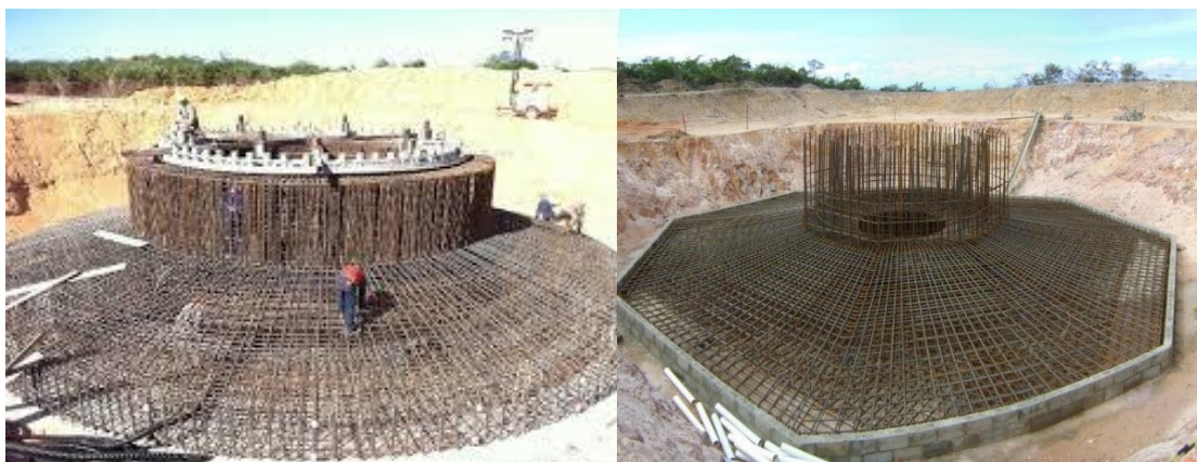
a) Fundação circular em laje
