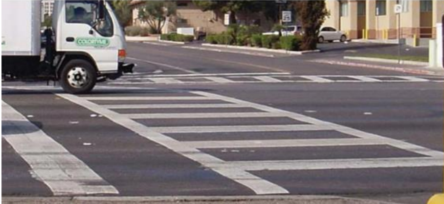
Figura 3.1: Faixa de pedestre de alta visibilidade
