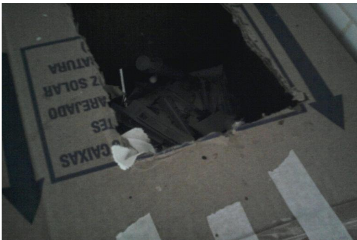
Figura 1 - Sala de Sutura, caixa de perfurocortante. Novembro de 2011
