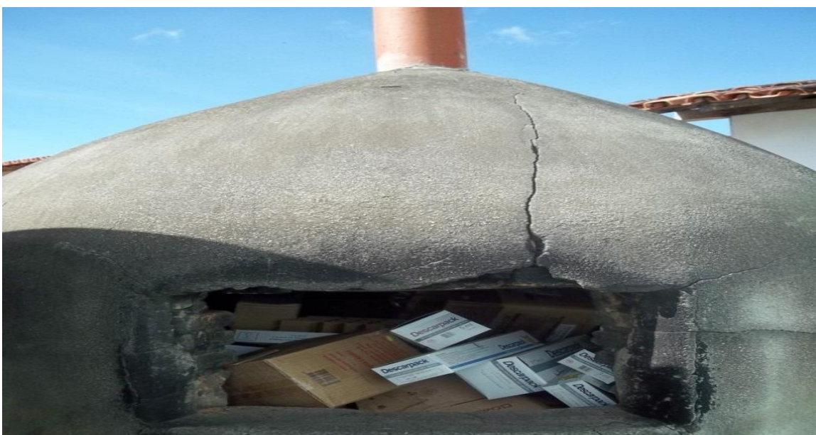
Figura 10 – Incinerador desativado vira abrigo intermediário de material reciclável. Novembro de 2011.
