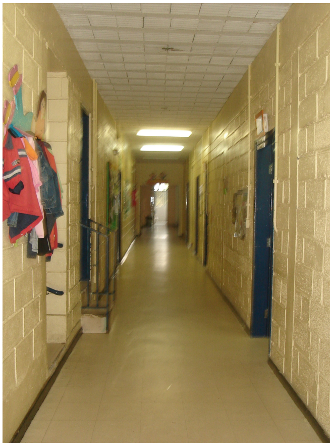
FOTO 09: CORREDOR – ACESSO PARA AS SALAS 1º ANDAR
