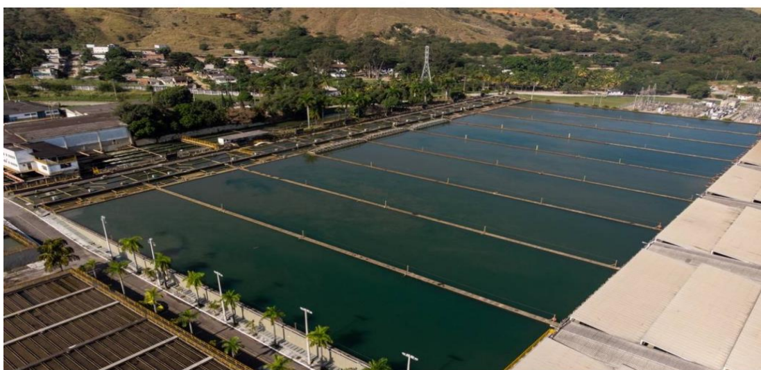
Estação de Tratamento de água (ETA) - Rio Guandu Foto: Brenno Carvalho / Agência O Globo
