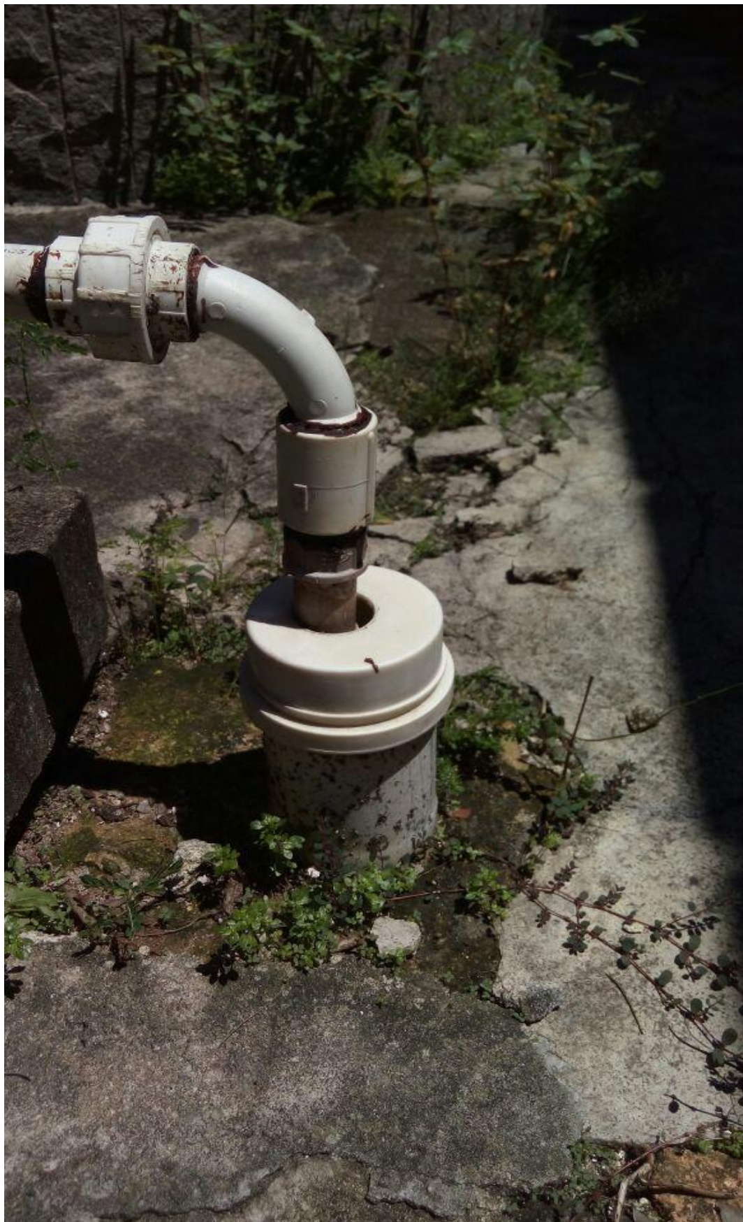
Figura 23. Instalação de poço artesiano na Escola Municipal Barro Branco, Duque de Caxias.
