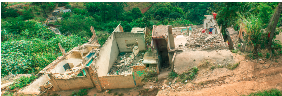
Figura 2 — Processo de demolição das Vilas no Morro do Papagaio
