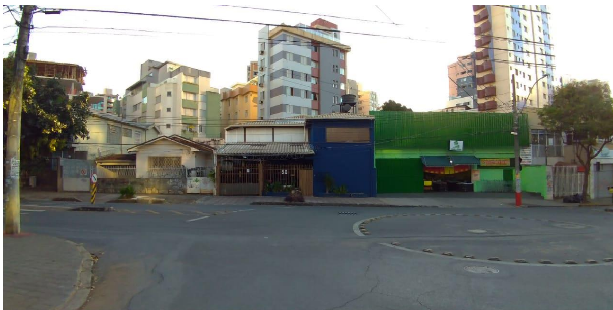
Figura 32 - Testada do lote e edificações adjacentes
