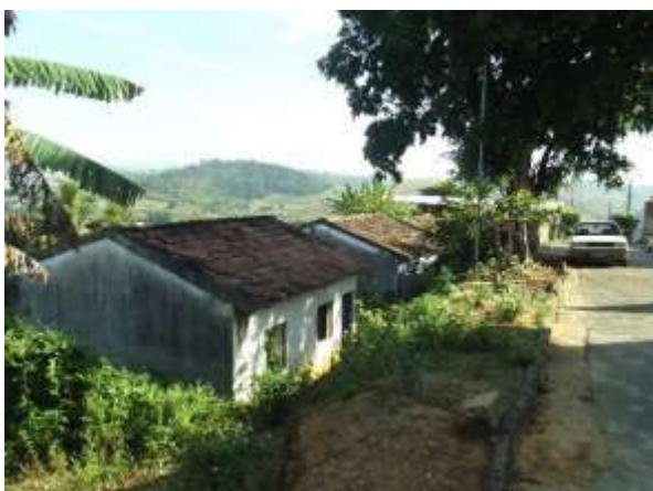
Figura 81 - Moradia no bairro São Pedro, abaixo do nível da rua que sofre com problemas de escoamento de águas pluviais.
