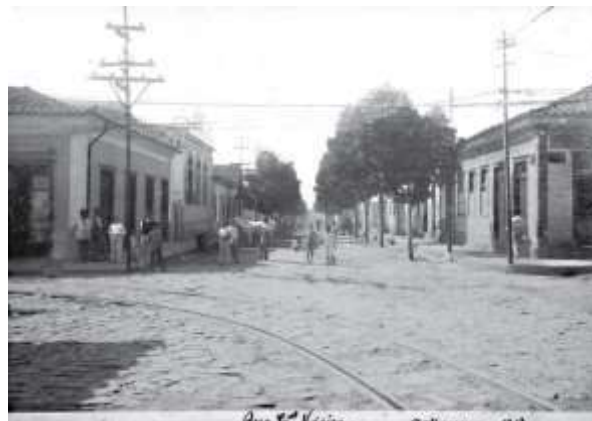
Figura 41 - Rua Coronel Vieira, destaque para os trilhos dos bondes e da arborização urbana fora dos passeios
