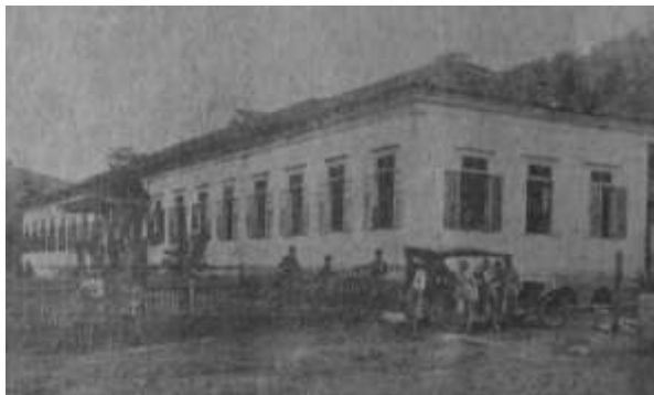
Figura 23 – Ginásio e Escola Normal de Cataguases na Chácara Granjaria
