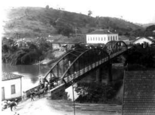
Figura 21 – Ponte metálica sobre o rio Pomba, no distrito de Vista Alegre
