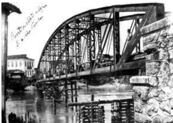
Figura 20 – Construção de ponte metálica sobre o rio Pomba, no distrito de Vista Alegre
