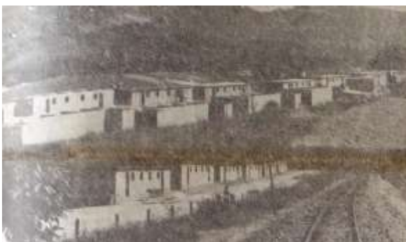
Figura 109 – Conjunto Ana Carrara: inaugurado em 1980, com 50 unidades habitacionais, construído pela Prefeitura e Estado, em sítio com pouca declividade, mas distante da mancha urbana.
