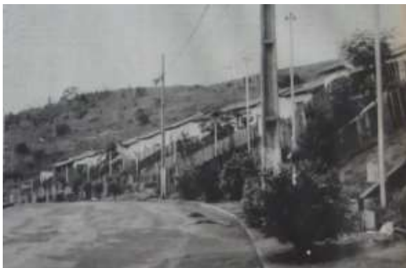
Figura 115 – Conjunto do Bairro São Cristóvão: 20 unidades habitacionais, inauguradas em 2000, construídas pelo programa Pró-moradia-habitar/CAIXA
