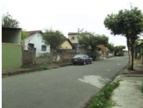
Figura 108 – Vista de uma rua do Conjunto Taquara Preta onde se mesclam moradias ainda originais com outras, ao fim da via, modificadas em dois pavimentos.
