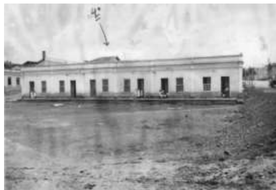
Figura 51 - Vila do Largo do Rosário, propriedade da família Peixoto. A Figura mostra a vila em parte mais baixa e um pequeno talude de terra referente a aterramento na rua Coronel Vieira feito para nivelar e evitarem-se enchentes recorrentes na área.
