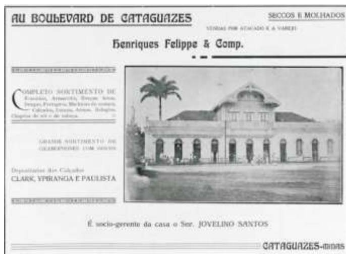
Figura 17 – Casa Henriques Felipe & Comp, localizada na Rua da Estação de frente para a avenida Astolfo Dutra; uma das primeiras grandes casas comerciais da cidade fundada em 1878, pelo imigrante português Henriques Felipe. O edifício da imagem foi construído em 1888.
