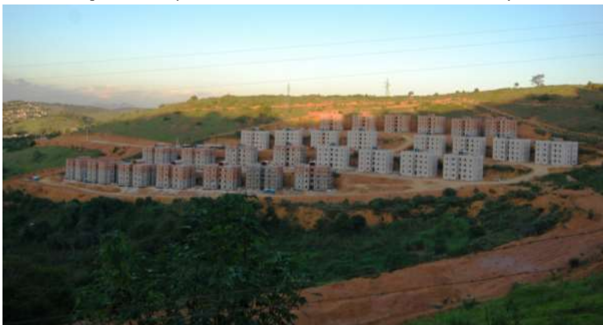
Figura 120 – Conjunto habitacional São Marcos ainda em fase de construção.
