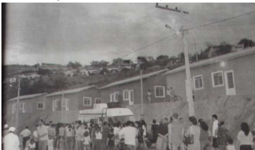
Figura 119 – Bairro São Cristóvão: 69 unidades habitacionais, inauguradas em 2006, construídas pela COHAB -MG
