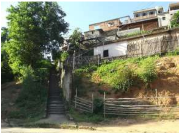
Figura 91 - Escadaria e moradia na encosta no bairro Thomé.
