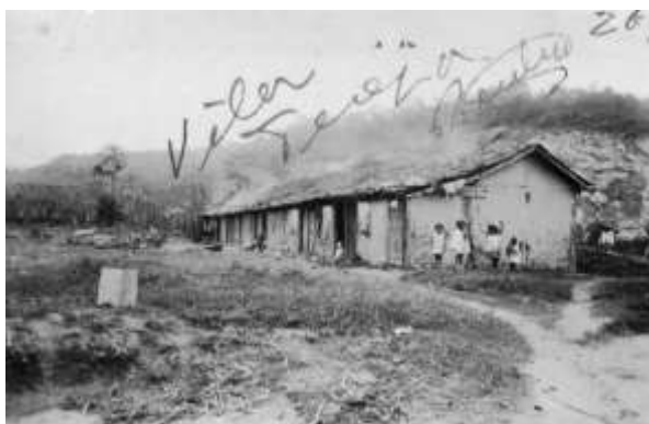
Figura 56 – Moradias da Vila Tereza na margem direita do rio Pomba.
