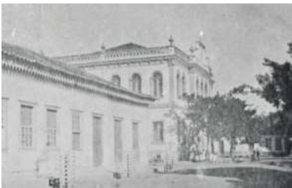
Figura 5 – Ao fundo, Paço Municipal inaugurado em 1894, de autoria do engenheiro Antônio Agostinho Horta Barbosa e cujo local já estava reservado desde 1879. A imagem mostra também a localização da arborização na via, fora do passeio.
