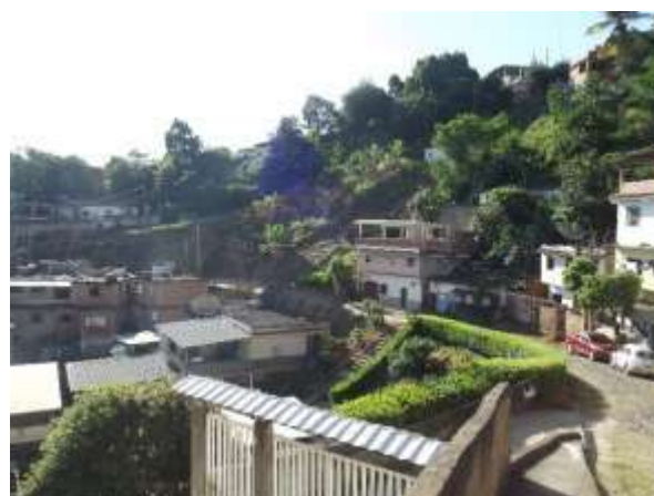
Figura 90 – Moradias na encosta e abaixo do nível da rua no bairro Thomé
