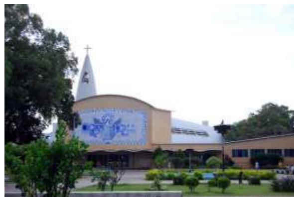
Figura 66 – Matriz de Santa Rita de Cássia. Edificação modernista que substitui a anterior.
