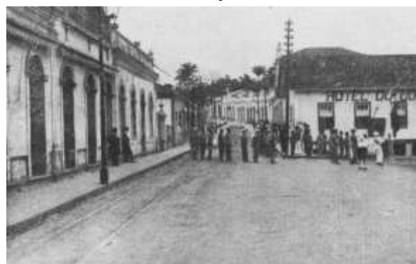
Figura 43 - Rua Cel. João Duarte, antiga rua da Estação
