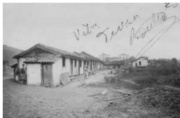
Figura 57 – Moradias da Vila Tereza na margem direita do rio Pomba.
