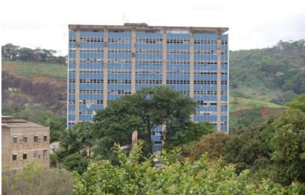
Figura 12 – Hospital de Cataguases, inaugurado em 1974, de autoria do arquiteto modernista Luzimar de Góes Telles, que substituiu o edifício anterior,
