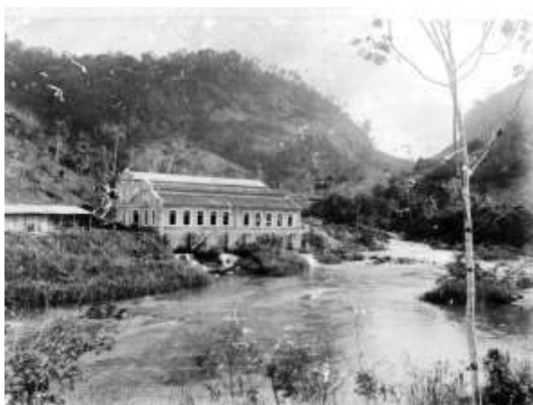
Figura 27 – Casa de força da Cia Força e Luz Cataguazes Leopoldina, Usina Maurício, nas margens do rio Novo.
