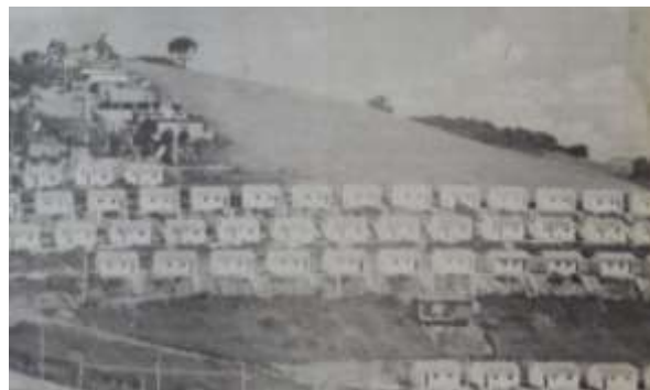
Figura 116 – Conjunto do Bairro São Pedro: 81 unidades habitacionais, inauguradas em 2000, construídas pelo programa Pró-moradia/Habitar Brasil/CAIXA
