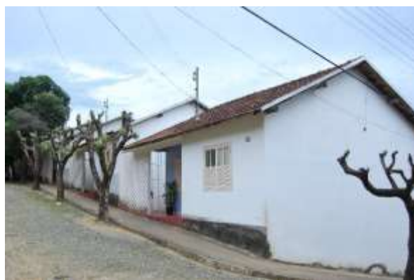
Figura 61 – Moradia da vila operária do Bairro Jardim – Tipo B. Sem afastamento frontal, alinhada à via.
