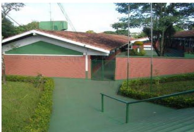
Figura 1: Fachada da E. M. Iracema Esteves
