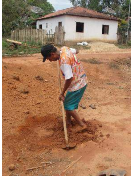
Figura 4 – Preparação da mistura com enxada e os pés
