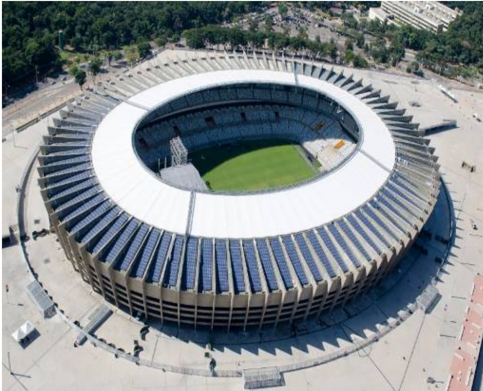
Figura 1 - UFV Mineirão construída na cobertura do Estádio de mesmo nome. Fonte: Cemig.
