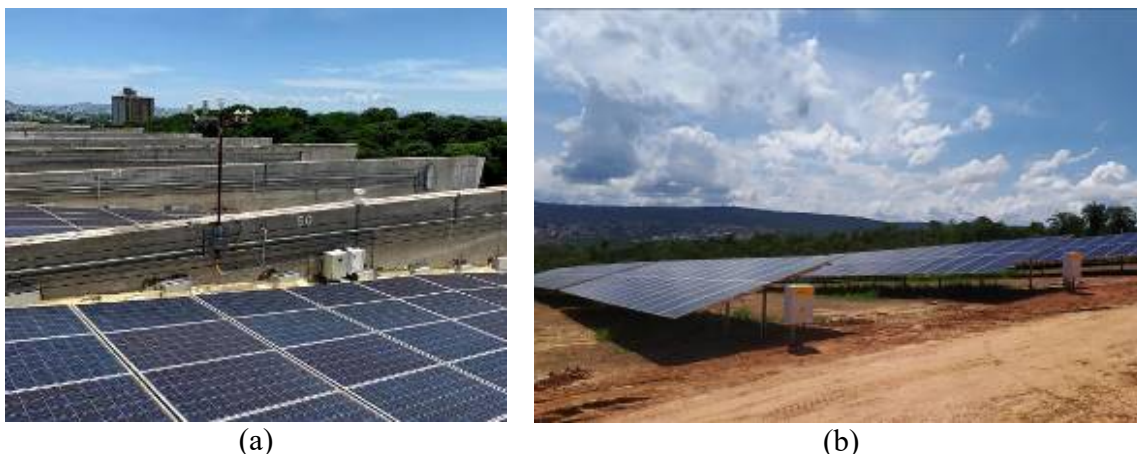
Figura 16 - Usina adaptada a construção (a) e otimizada para maior rendimento (b). Fonte: próprio autor.
