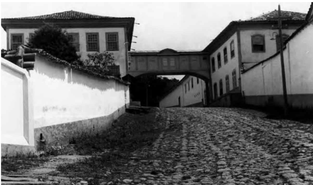
Figura 40 - Passadiço da Casa da Glória, sobre rua homônima, Diamantina (MG)
