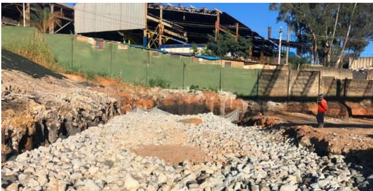
Imagem 22 – Águlhamento com rachão, fonte: arquivo pessoal autor (maio 2019).
