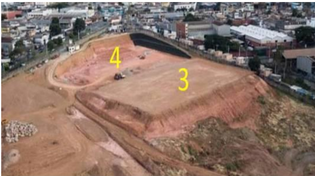
Imagem 8 – Finalização do aterro de pré-carregamento área 3a e área 4, fonte: arquivo da empresa Alfa (abril 2018).
