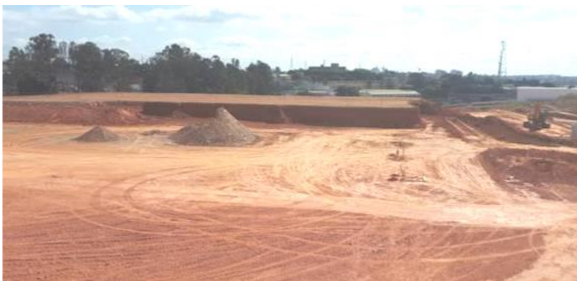
Imagem 10 – Início da remoção do aterro de pré-carregamento das áreas 3a e área 4, fonte: arquivo pessoal autor (junho 2018).
