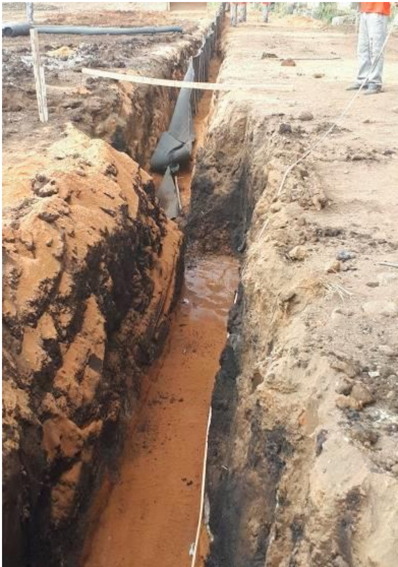
Imagem 13 – Execução de drenos espinha de peixe e colchão de areia nas áreas 3b e 3c, fonte: arquivo pessoal autor (junho 2018).
