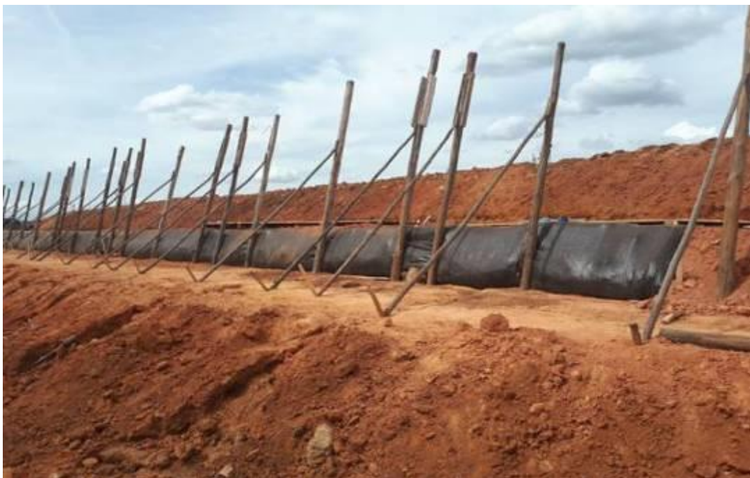
Imagem 7 – Execução do aterro envolvido – áreas 3a e 4, fonte: arquivo pessoal do autor (março 2018).
