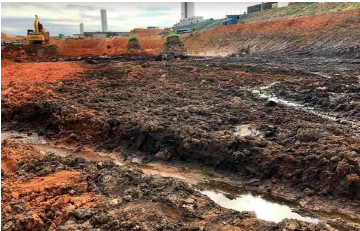
Imagem 20 – Corte do aterro de pré-carregamento das áreas 3b e 3c, fonte: arquivo pessoal autor (outubro 2018).
