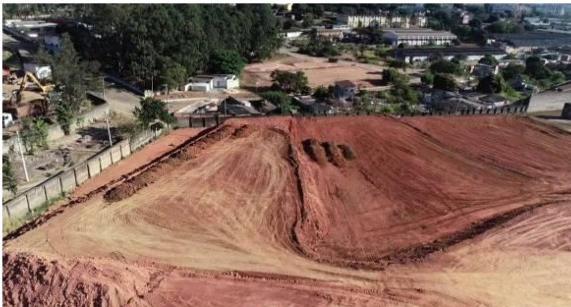
Imagem 18 – Conclusão do aterro de pré-carregamento das áreas 3b e 3c, fonte: arquivo da empresa Alfa (agosto 2018).
