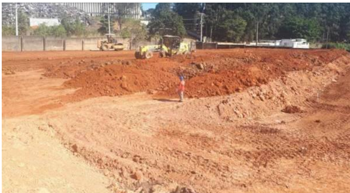
Imagem 15 – Início do aterro de pré-carregamento da área 3b, fonte: arquivo pessoal autor (junho 2018).
