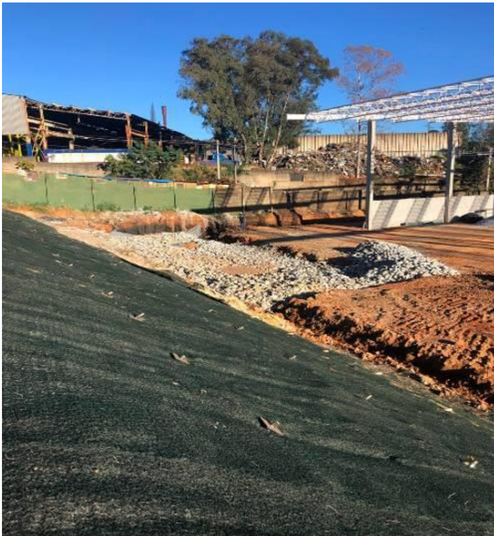
Imagem 23 – Águlhamento com rachão, fonte: arquivo pessoal autor (maio 2019).
