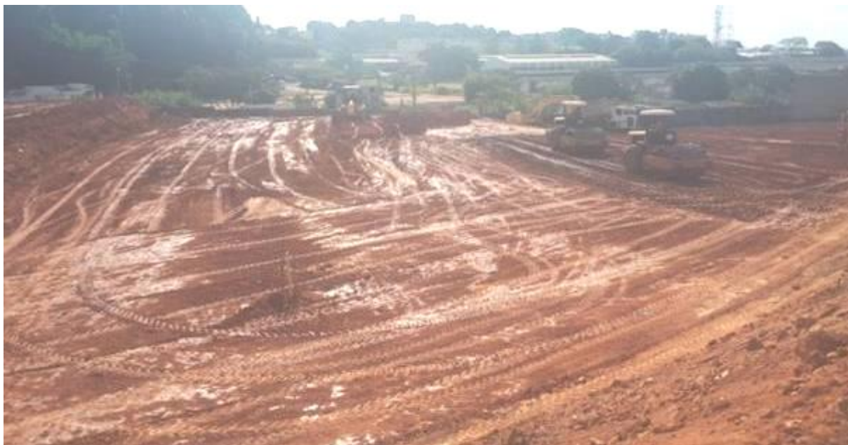
Imagem 16 – Aterro de pré-carregamento da área 3c, fonte: arquivo pessoal autor (agosto 2018).
