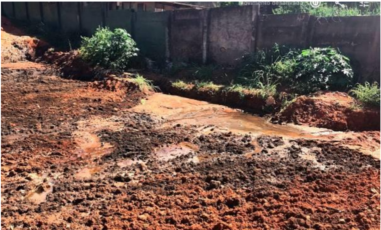
Imagem 11 – Afloramento de lençol freático na região 3b, fonte: arquivo pessoal autor (junho 2018).
