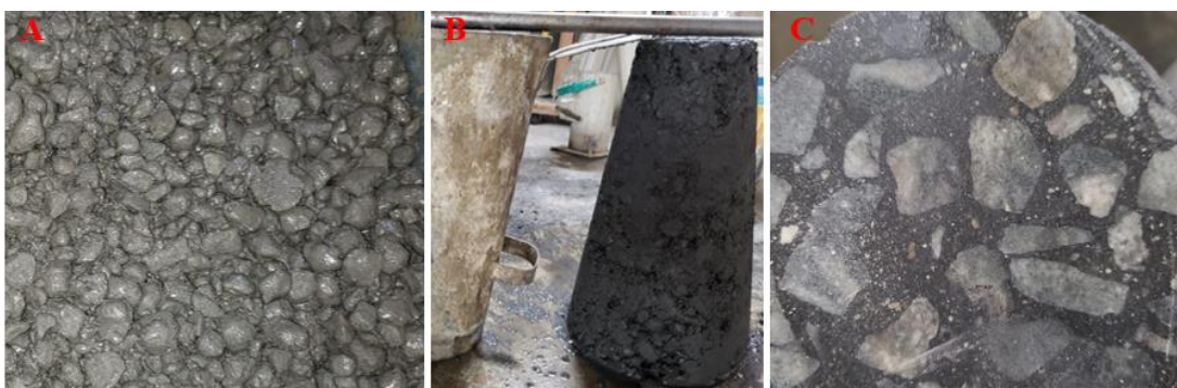
Figura 24: Aspecto e trabalhabilidade do concreto – dosagem 3 (Fonte: o próprio autor)
