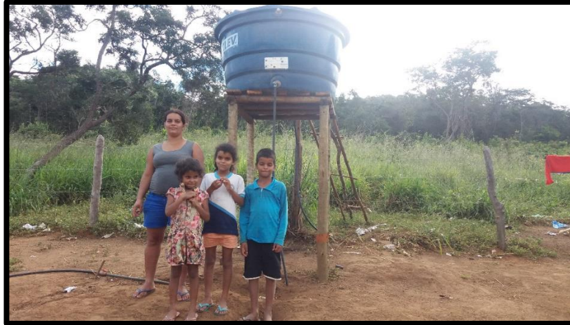
Figura 11 – Construção de sistema de distribuição de água comunidade Córrego da Lapa.
