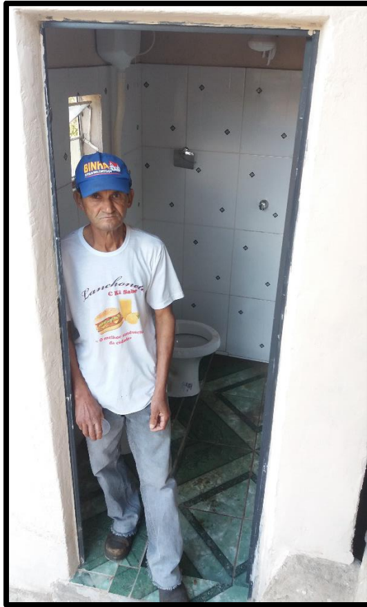
Figura 13 – Construção de banheiros na comunidade Córrego da Lapa.
