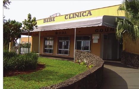
Figura 6 - Visão externa do antigo prédio da Bebê Clínica.
