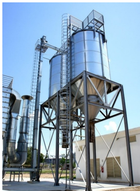
(b) Silo Multicelular Elevado
