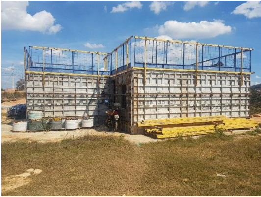
Figura 3 – Execução de parede de concreto moldada in loco
