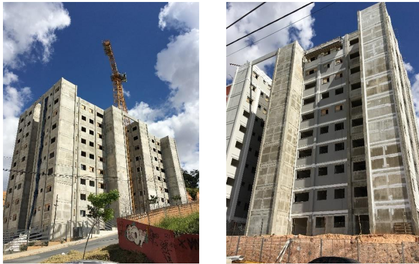
Figura 5 – Sistema Construtivo em Painéis Pré-Fabricados – Estudo de Caso 1
