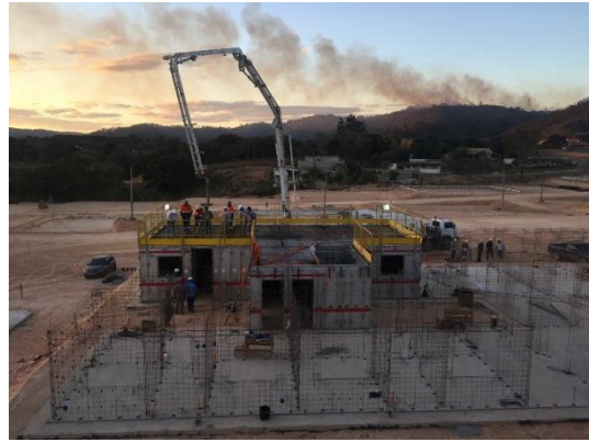
Figura 3 – Execução de parede de concreto moldada in loco
