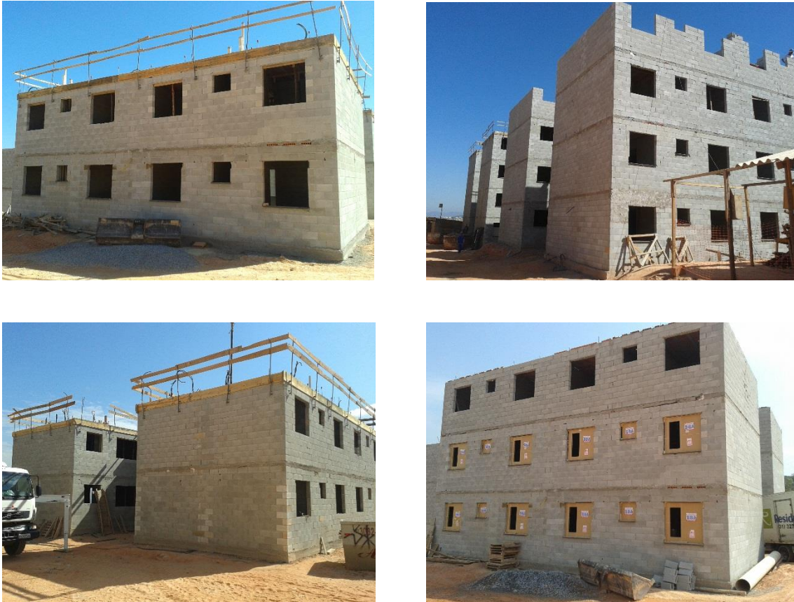
Figura 2 – Execução de alvenaria estrutural em bloco de concreto
