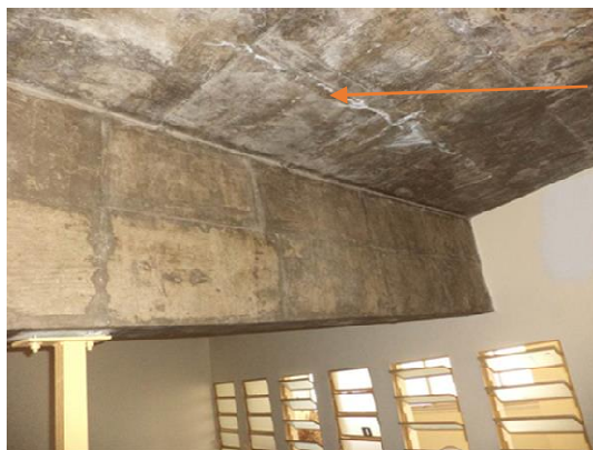
Figura 26: Ilustração da eflorescência apresentada na loja 12.
