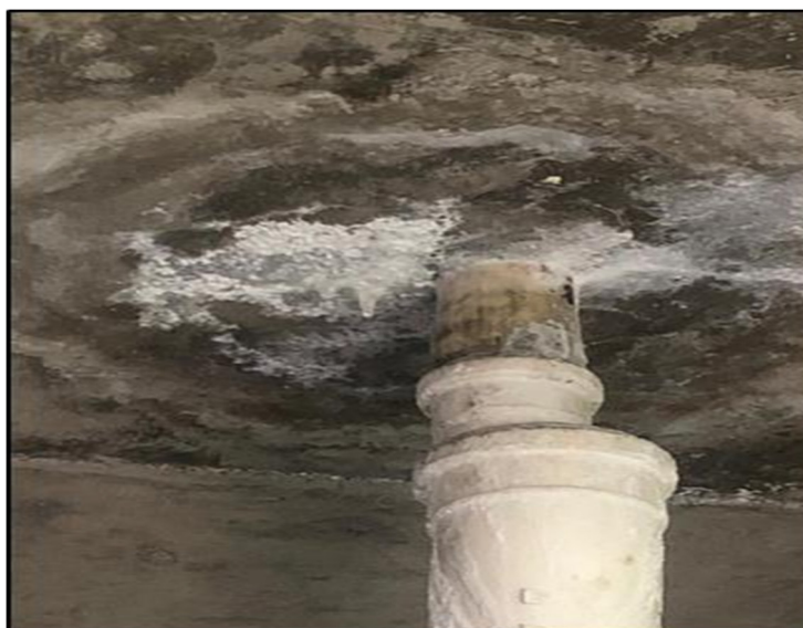
Figura 1: Eflorescência no concreto armado
