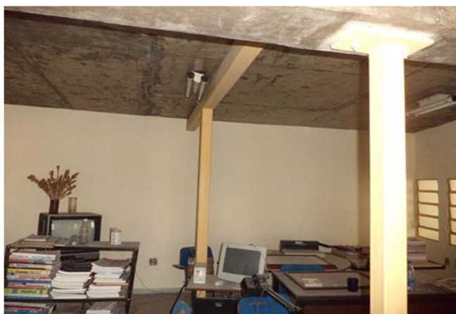
Figura 25: ilustração de apoios metálicos na loja 12
