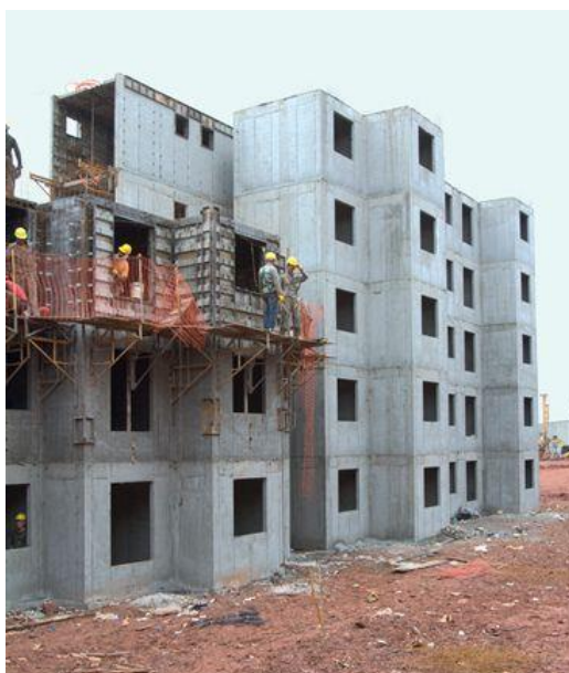
Figura 1 - Edificação em Parede de Concreto – Execução
