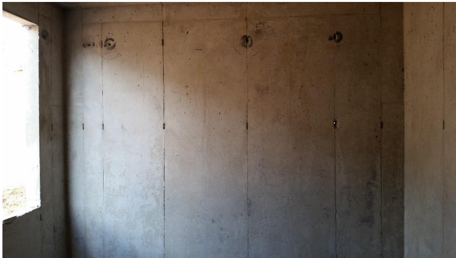
Figura 2 - Superfície da Parede de concreto moldada in loco
