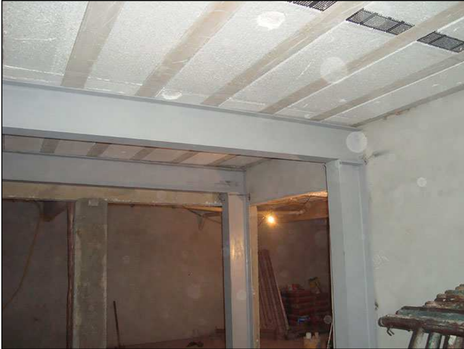
Figura 7: Reforço estrutural em estrutura metálica.
