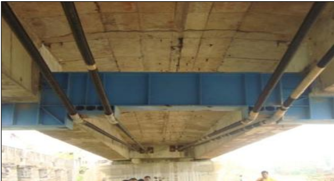
Figura 9: Reforço para estruturas com protensão externa.
