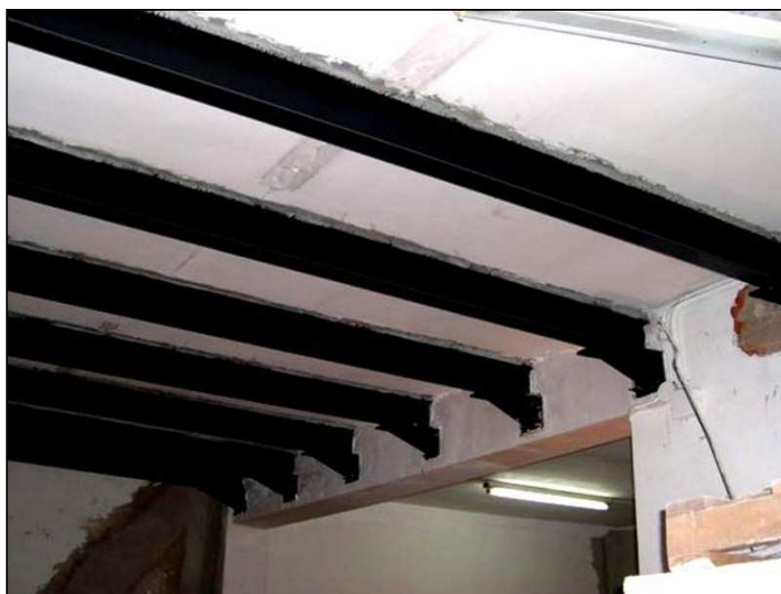
Figura 6: Reforço com perfis metálicos.
