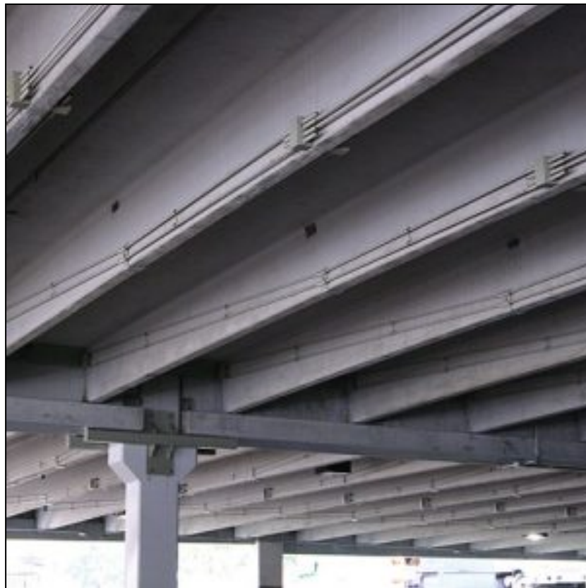
Figura 8: Reforço para estruturas com protensão externa.
