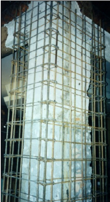
Figura 5: Encamisamento de pilar e encamisamento de pilar-forma.
