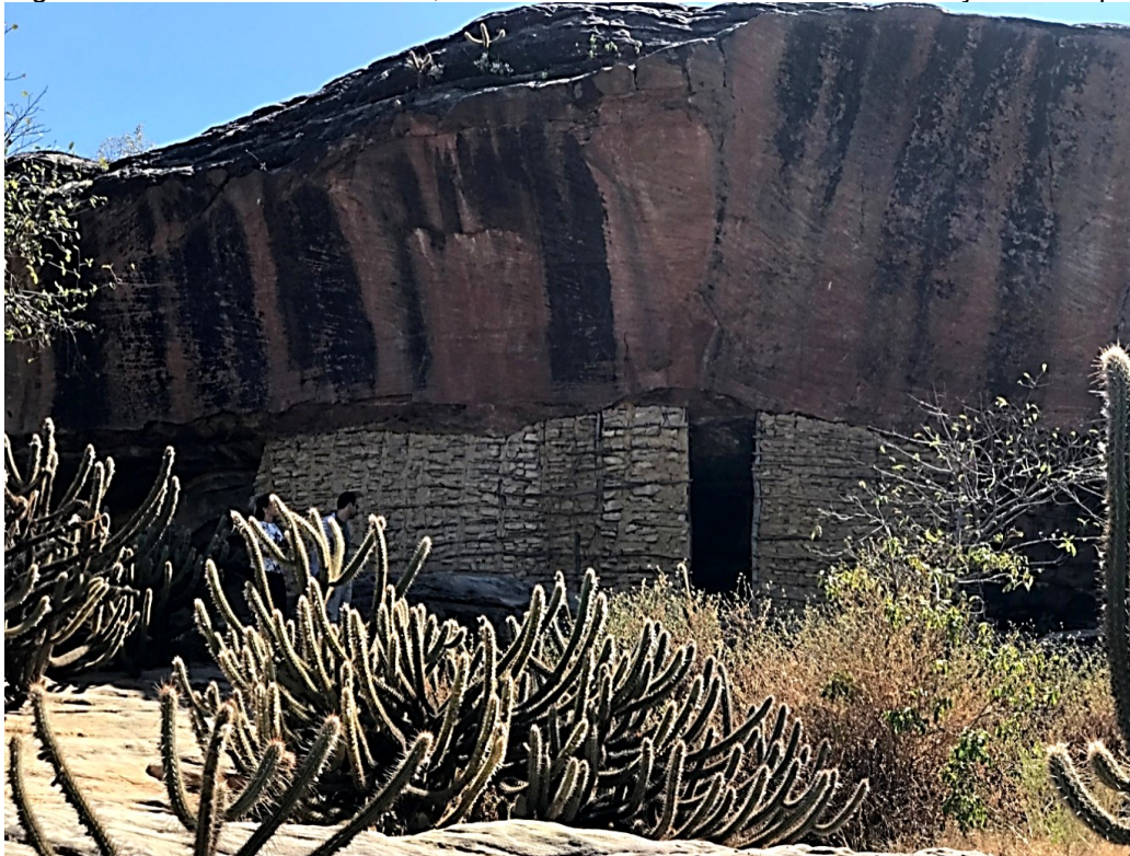
Figura 51 - Toca do João Sabino, vista da fachada de frente com as vedações de taipa
