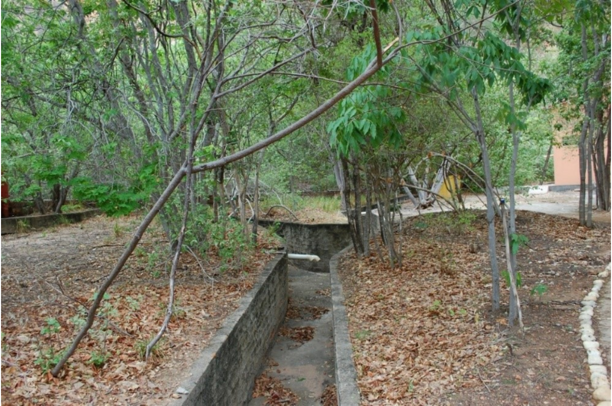
Figura 5 - Canaletas de drenagem do entorno do Sítio BPF/PARNA SC
