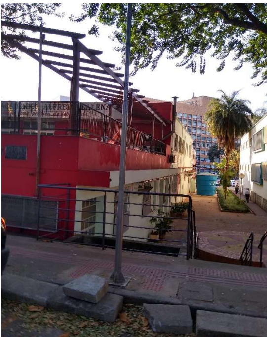
Figura 481 - Visão de um corredor de acesso à parte de trás do prédio da faculdade
