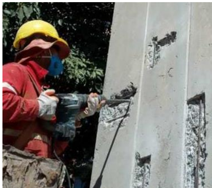
Figura 23- Escarificação da estrutura do Monumento na Praça Rio Branco
