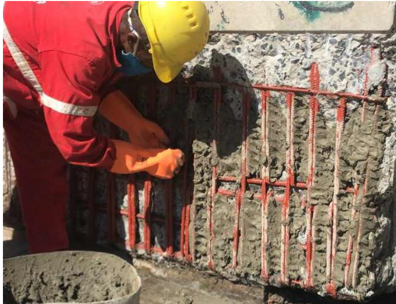
Figura 40- Aplicação de argamassa polimérica manualmente
