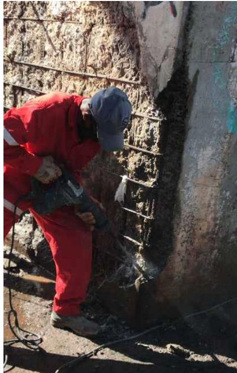
Figura 22- Escarificação do pilar do viaduto da Lagoinha com uso de martelete 10Kg
