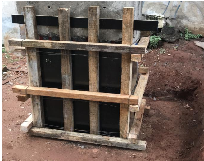
Figura 44- Montagem de forma no local do reparo mais profundo
