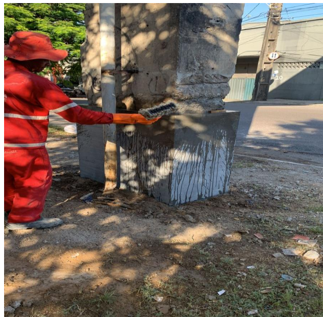
Figura 46- Cura do reparo com aspersão de água
