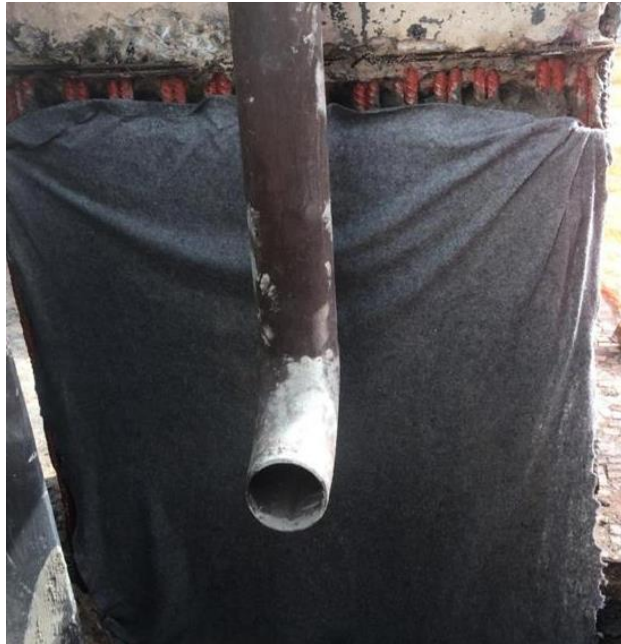
Figura 47- Cura do local de reparo com uso de manta geotêxtil úmida
