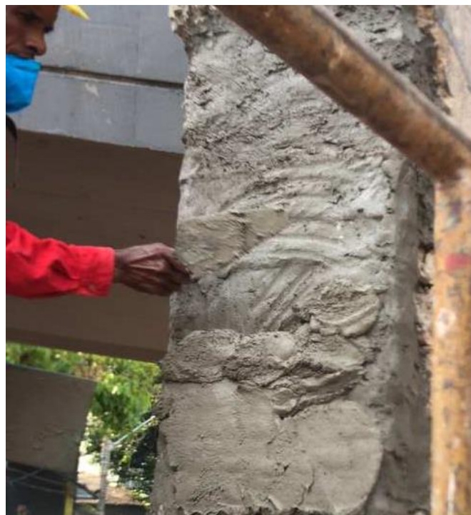
Figura 42- Aplicação de argamassa com auxílio de colher de pedreiro
