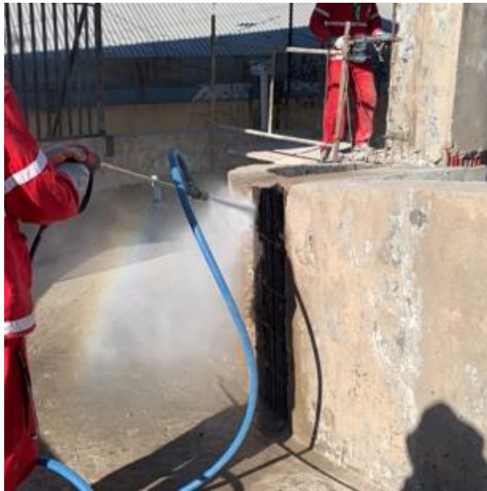
Figura 31- Jateamento de abrasivo na armadura do pilar
