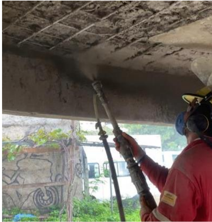
Figura 41- Aplicação de argamassa polimérica por projeção
