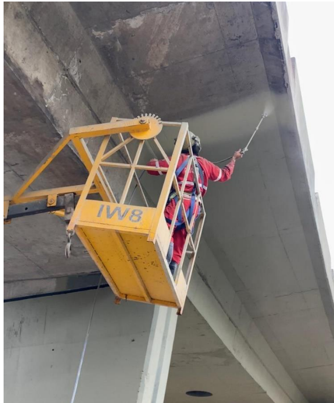
Figura 49- Pintura da estrutura com utilização de máquina de pintura Airless
