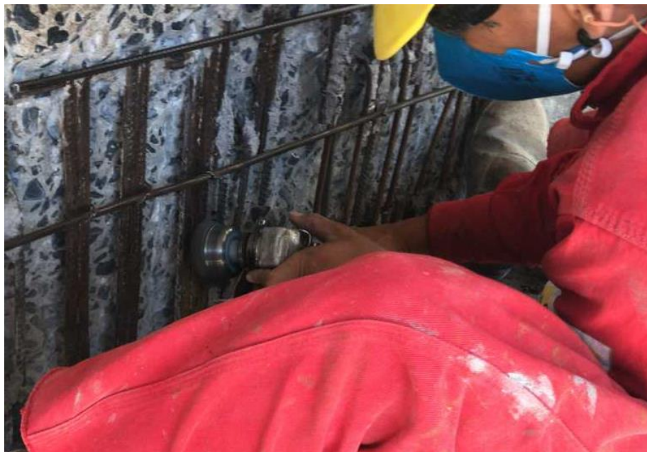
Figura 33- Limpeza das armaduras de forma mecanizada, utilizando lixadeira e furadeira com escovas metálicas
