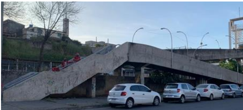
Figura 21- Passarela de acesso a estação de metrô Vila Oeste depois da lavagem
