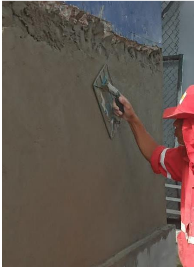
Figura 43- Acabamento do reparo
