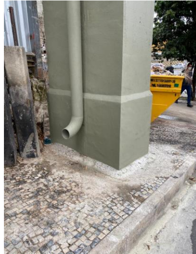
Figura 51- Depois das intervenções
