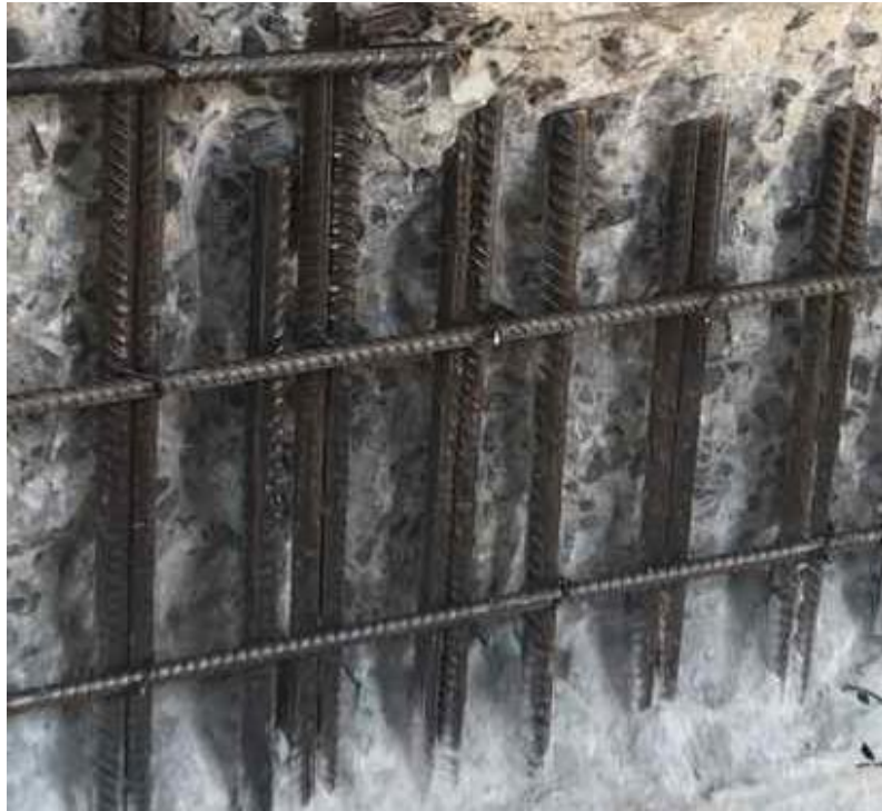
Figura 34 - Armadura lima com uso de escovas metálicas
