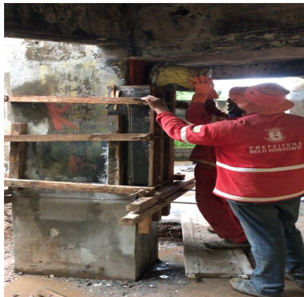
Figura 45- Preenchimento da forma com microconcreto
