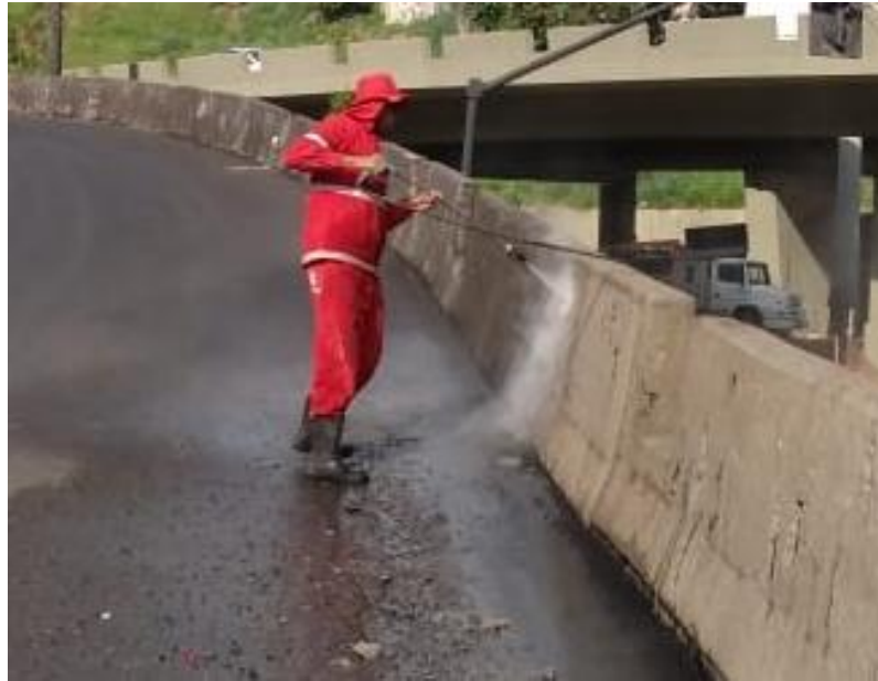
Figura 19- Limpeza das new Jersey do complexo da Lagoinha
