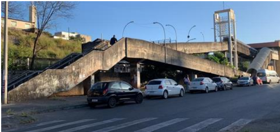
Figura 20- Passarela de acesso a estação de metrô Vila Oeste antes da lavagem
