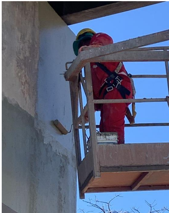
Figura 48- Pintura da estrutura com utilização de rolo de lã
