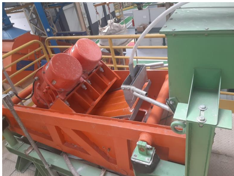
Figura 3.2 – Instalação da peneira de alta frequência de laboratório.
