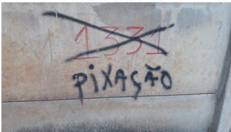
Figura 10 - Pixo: Muro da construção da estação Moema da linha Lilás do metro de São Paulo.
