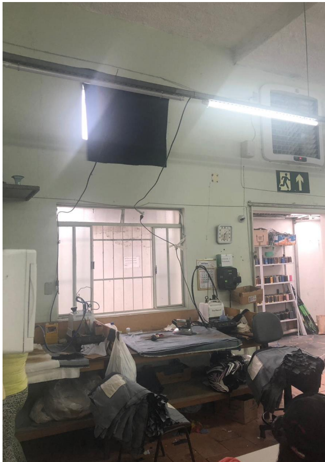
Figura 12 - Vedação de janela alta no ambiente
