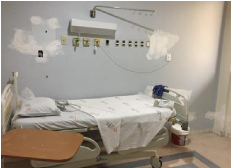
Figura 7 - Imagem de leito de internação após limpeza e manutenção corretiva
