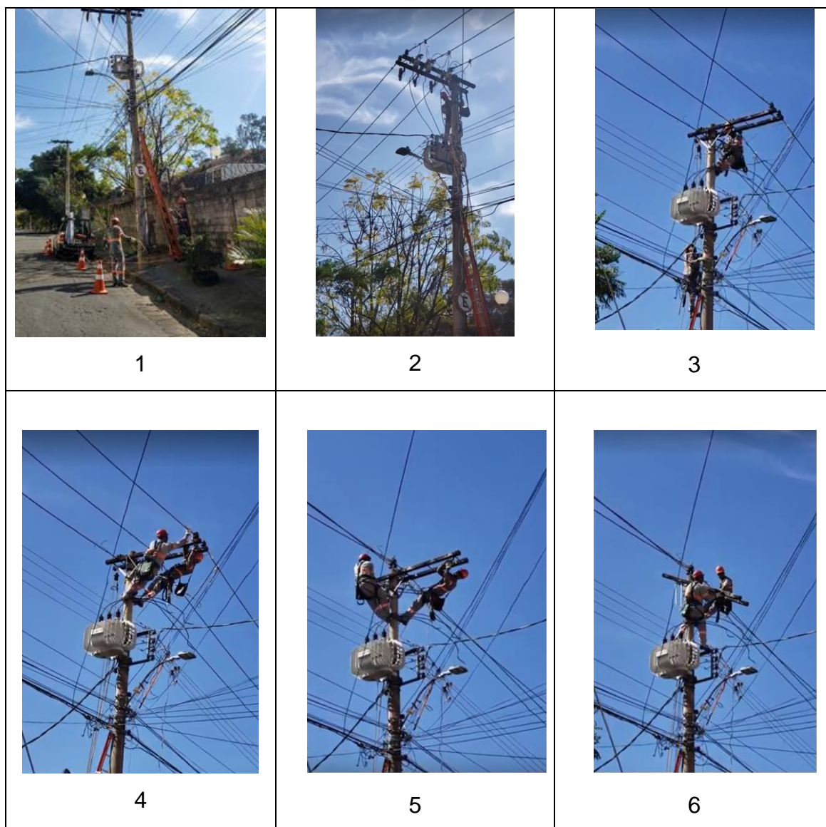
Figura 9: Etapas da atividade de troca de cruzetas e para-raios
