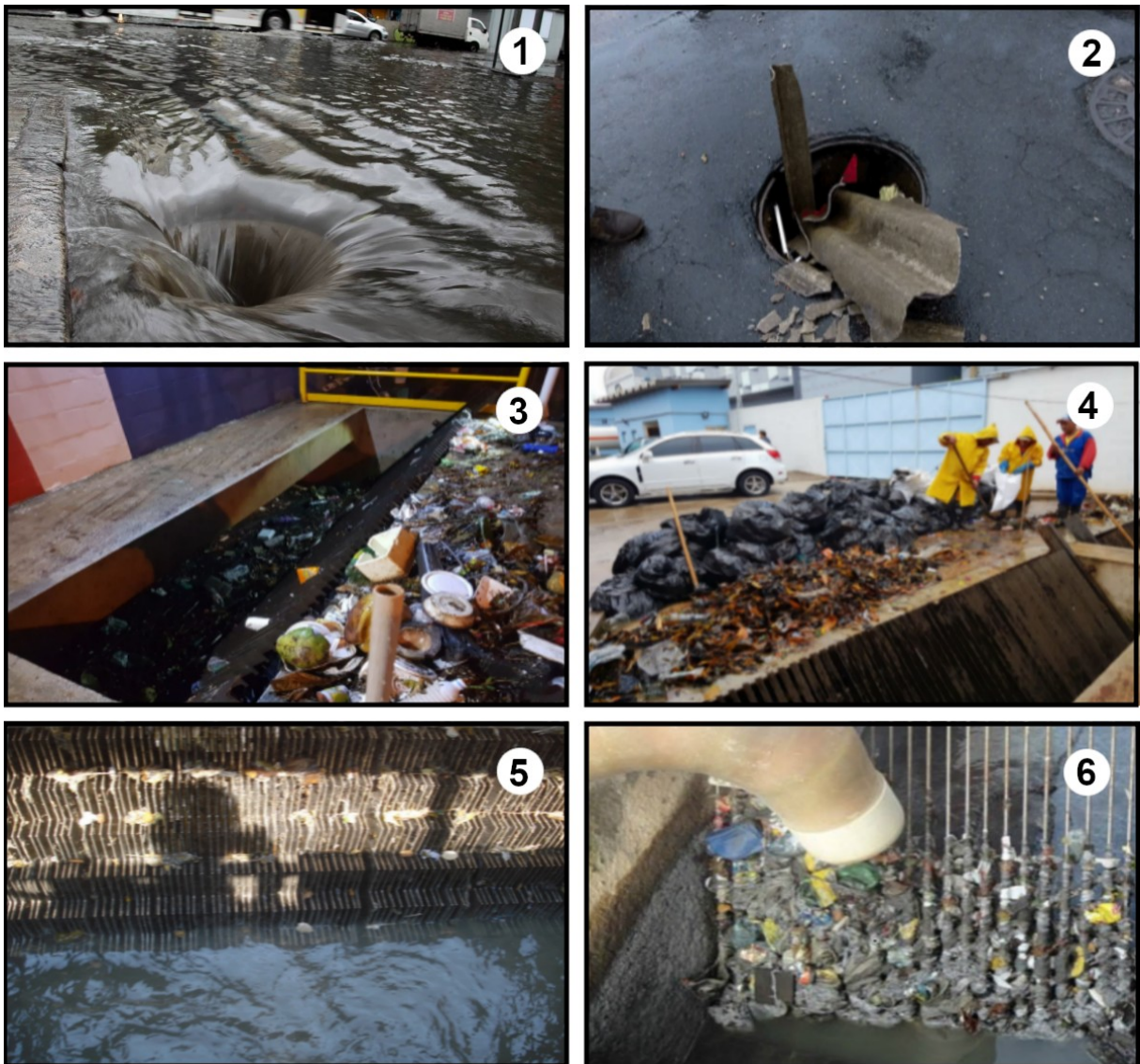
Figura 6: Problemas causados por águas pluviais e detritos
