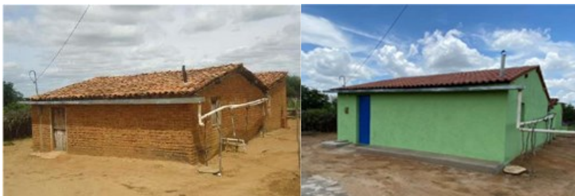
Figura 8 e 9 – Residência antes e depois da reforma
