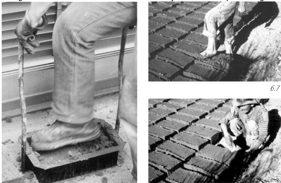
Figura 5 – Preenchimento das formas e colocação dos adobes para secagem
