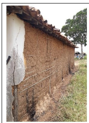
Alessandra da Silva Vista lateral – Parede de taipa exposta sem revestimento.
