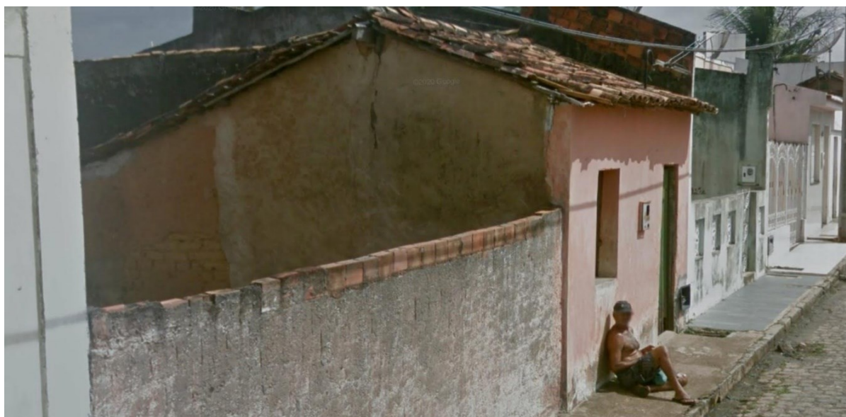
Figura 61 – Edificação construída com adobe no município de Frei Paulo/SE
