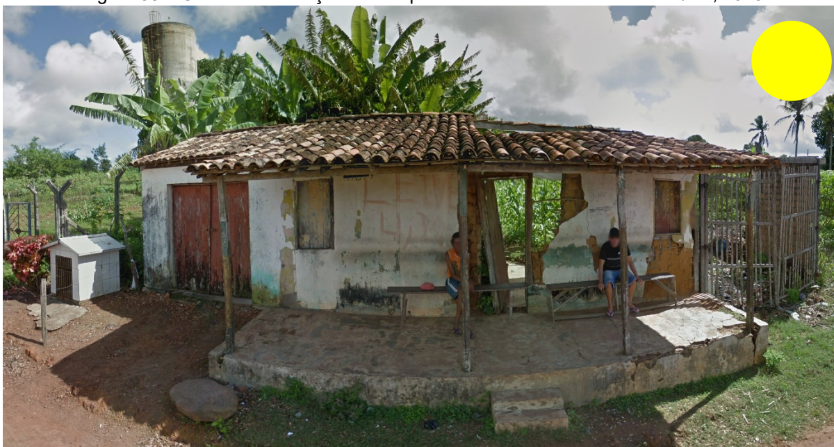
Figura 58 – Casa em demolição. Município de Nossa Senhora das Dores/SE, 2015
