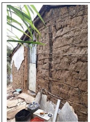
José Romeo dos Santos Vista lateral (1) – Parede de taipa exposta sem revestimento.
