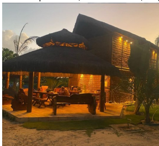
Figura 47 – Pousada em construção utilizando a técnica da taipa de mão, Ilha Mem de Sá, Sergipe
