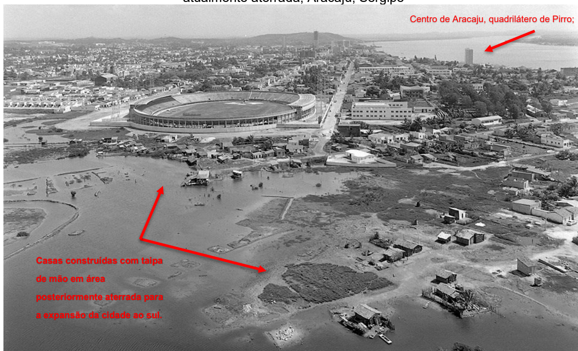
Figura 24 – Moradias de taipa de mão construídas próximo ao Estádio Lourival Batista, área atualmente aterrada, Aracaju, Sergipe
