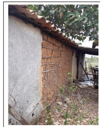
José Aloízio de Jesus Farias Vista lateral – Parede de taipa exposta sem revestimento.
