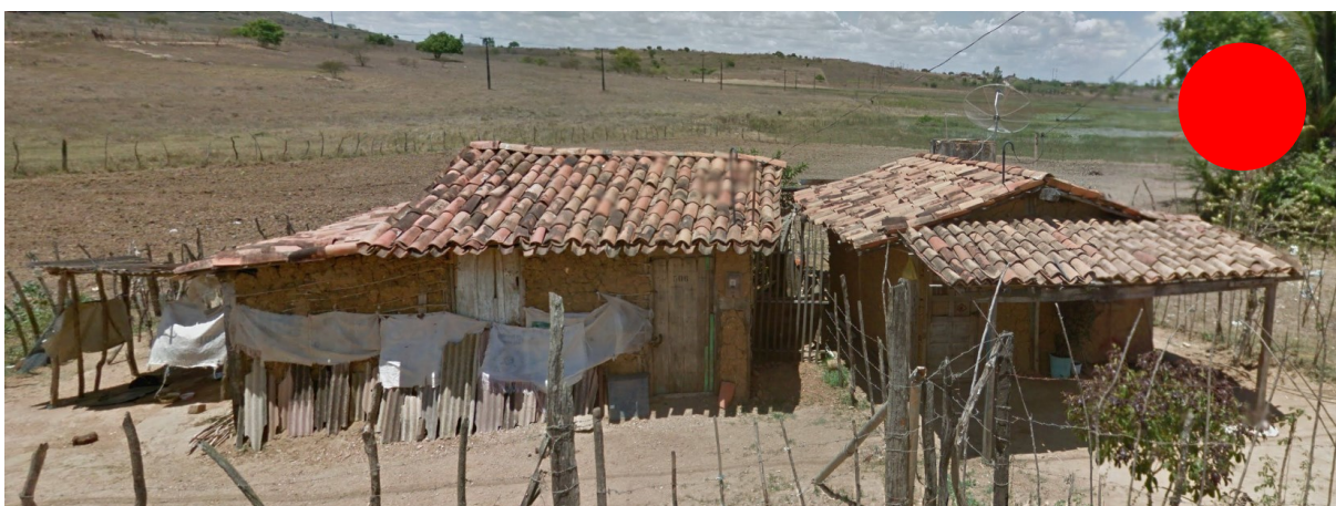
Figura 56 – Casas em taipa de mão sem revestimento. Município de Propriá/SE, 2012
