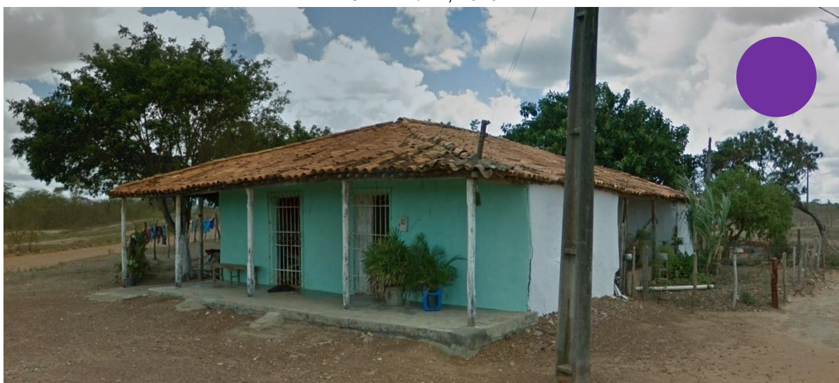
Figura 57 – Casa com todas as paredes externas revestidas. Aparenta ter sido construída em taipa de mão, mas não é possível comprovar apenas com o levantamento digital. Município de Graccho Cardoso/SE, 2019
