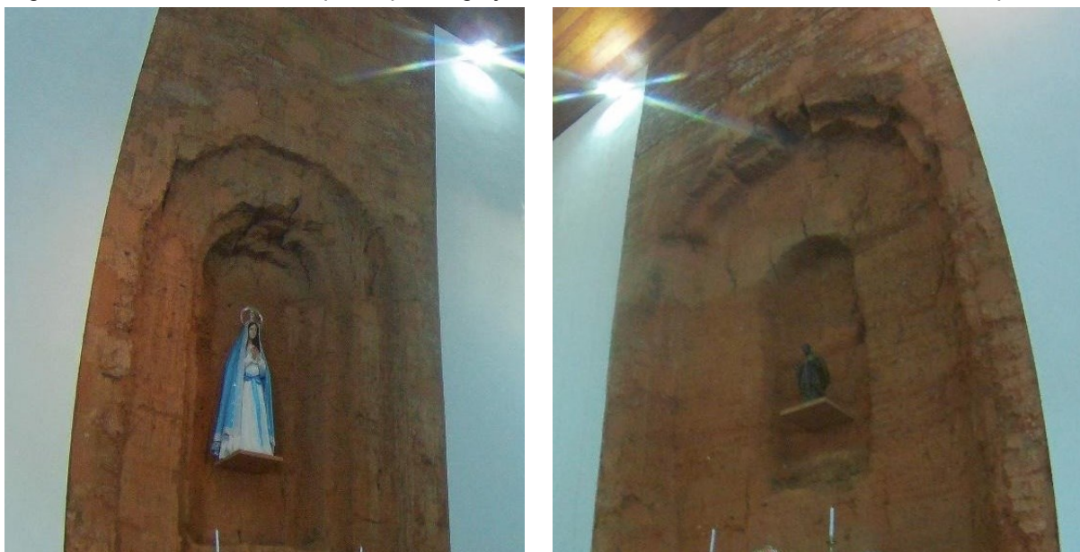
Figura 2 e 3 – Paredes em taipa de pilão, Igreja Matriz de Nossa Senhora do Rosário, Pirenópolis/GO
