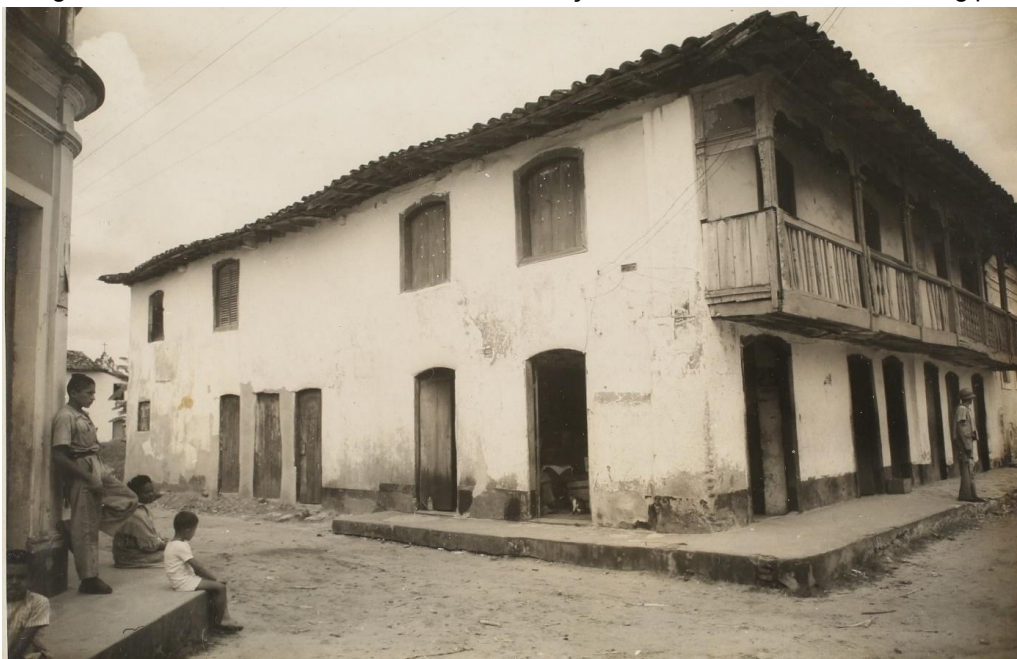
Figura 20 – Casarão de balcão corrido na Praça da Matriz, São Cristóvão, Sergipe
