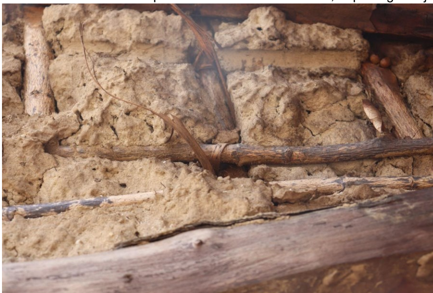
Figura 43 – Detalhe da técnica da taipa de mão na Ilha Mem de Sá, Itaporanga d’Ajuda, Sergipe
