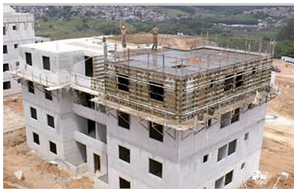
Figura 2. Edifício em parede de concreto
