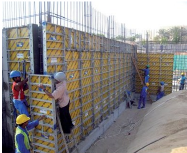
Figura 13. Fôrmas tipo Parede
