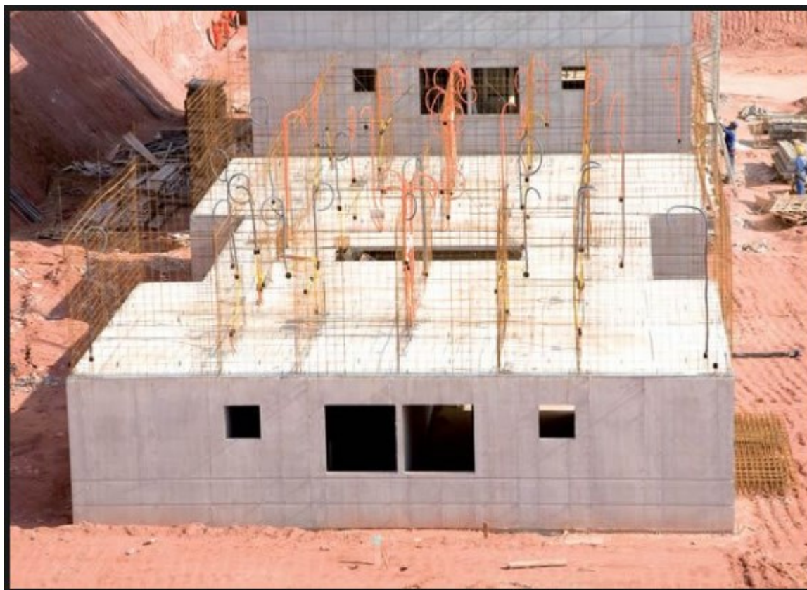
Figura 7. Execução das armaduras
