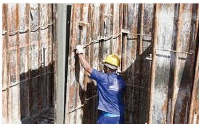
Figura 18. Desforma paredes de concreto
