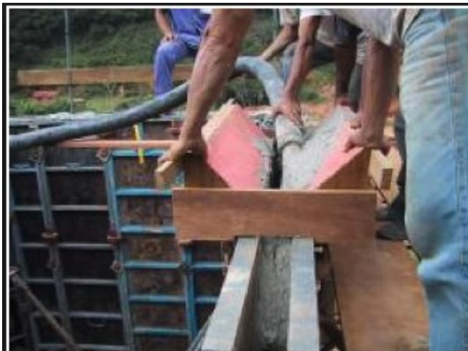
Figura 17. Utilização de calha para o lançamento de concreto
