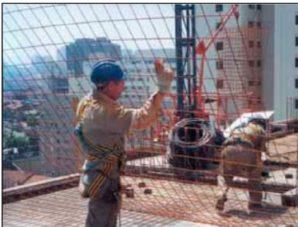
Figura 15. Posicionamento das armaduras nas lajes
