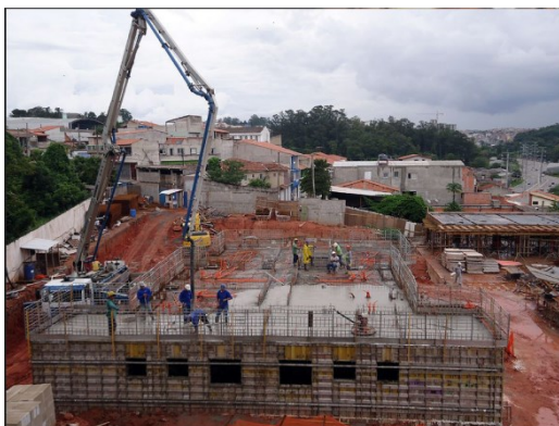
Figura 3. Prédio Vista Bella: consumo de 6.700 m 3 de concreto autoadensável
