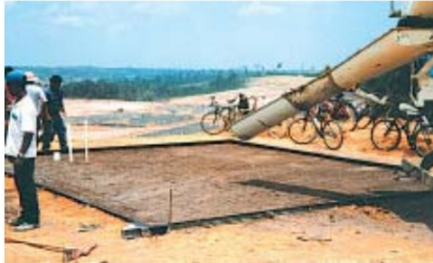
Figura 5. Concretagem com caminhão betoneira
