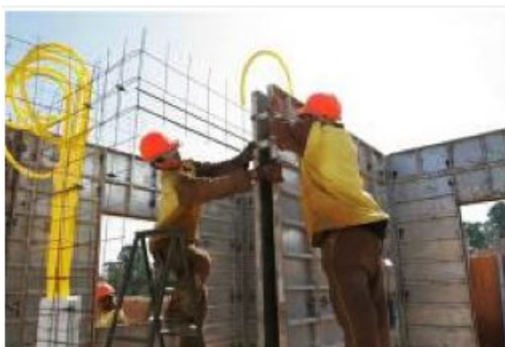
Figura 10. Montagem dos painéis internos depois externos
