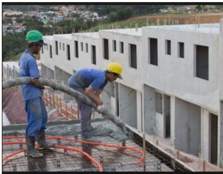
Figura 16. Lançamento de concreto
