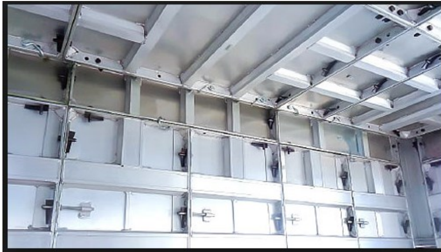
Figura 12. Fôrmas tipo Mesa/parede
