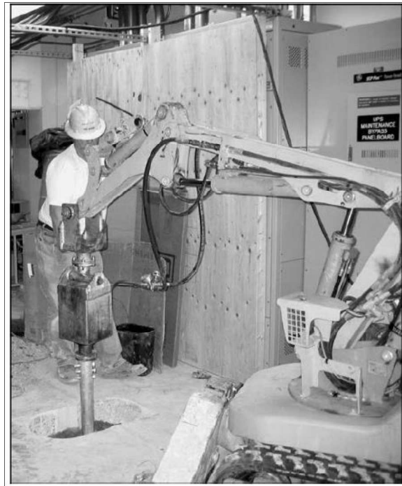
Figura 11 – Instalação de estaca helicoidal em local com acesso reduzido
