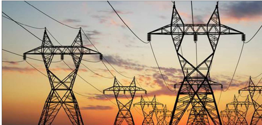
Figura 1 – Torres de transmissão de energia
