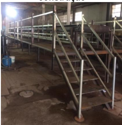
Figura 20 - Foto da esteira durante a construção
