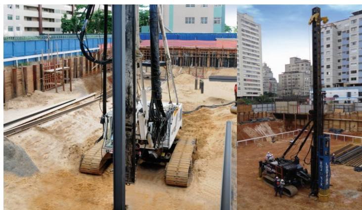
Figura 14- Cravação da Estaca Metálica
