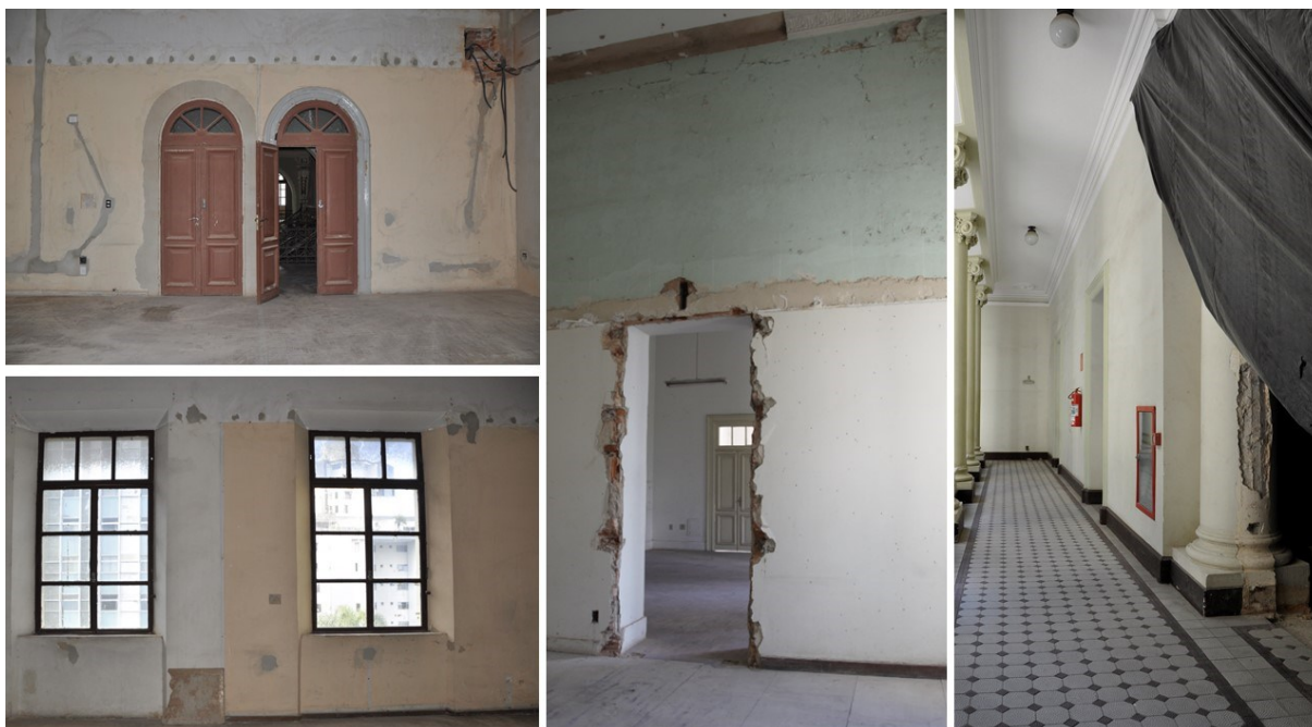
Figura 65 - Detalhe de intervenções no interior da edificação
