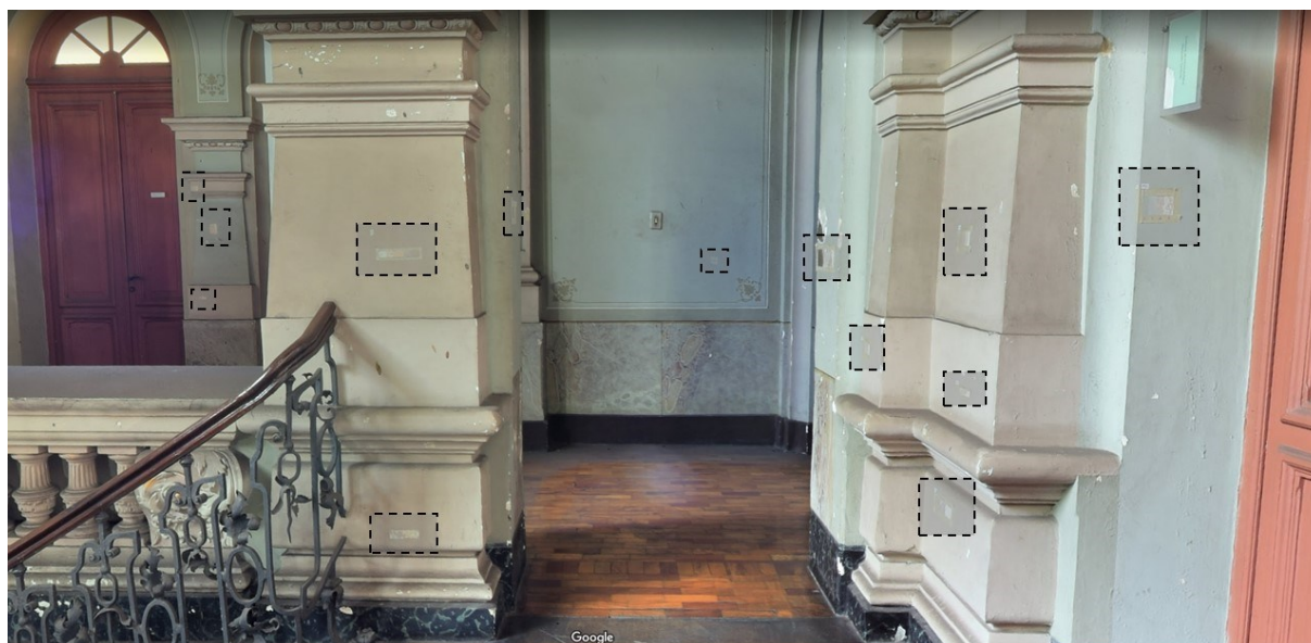
Figura 66 - Destaques dos estudos estratigráficos no segundo pavimento
