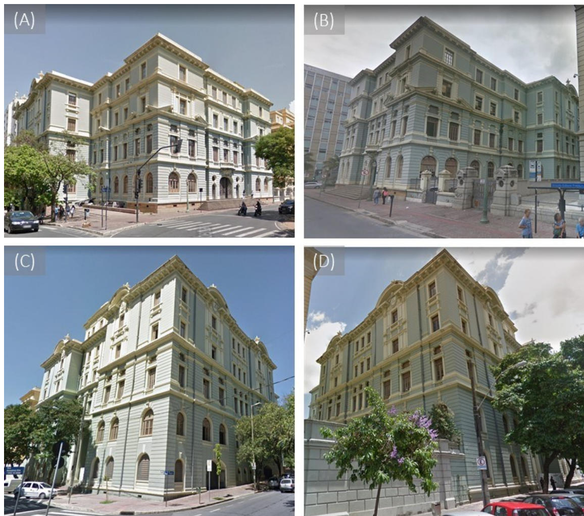
Figura 64 - Fachadas do edifício estudo de caso
