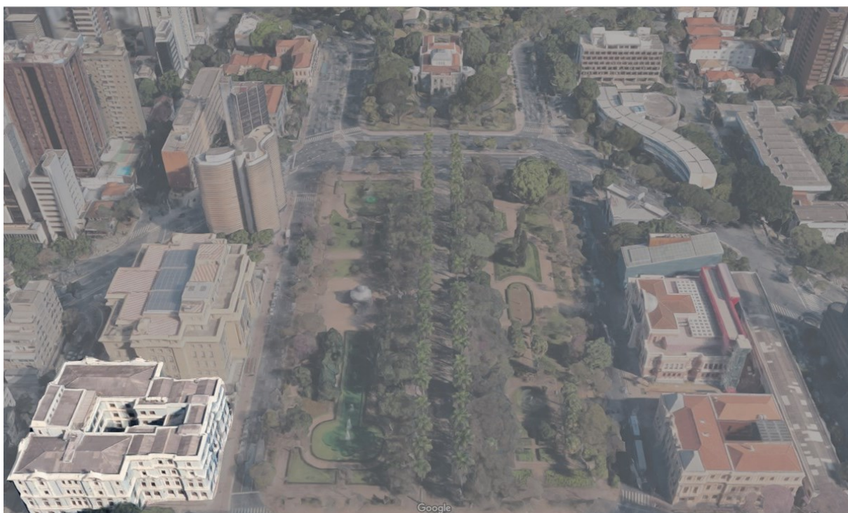
Figura 2 - Praça da Liberdade (Belo Horizonte, Minas Gerais) com destaque para o edifício estudo de caso
