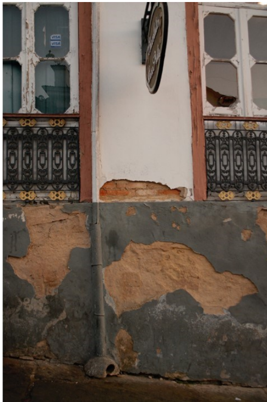
Figura 8 - Patologias por incompatibilidade física e química em edificações na cidade de Ouro Preto, Minas Gerais
