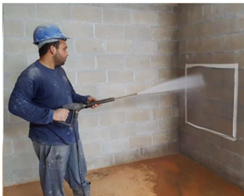
Figura 2: Limpeza da base
