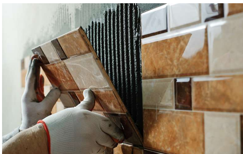
Figura 7: Aplicação de revestimento de cerâmica
