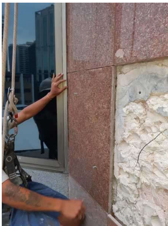
Figura 9: Aplicação de granito com argamassa colante
