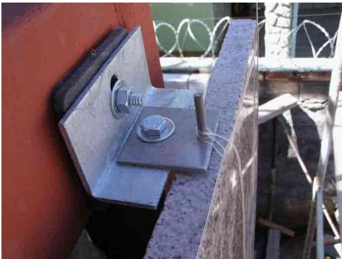
Figura 10: Sistemas com fixação de inserts metálicos
