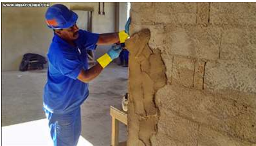
Figura 4: Aplicação do reboco
