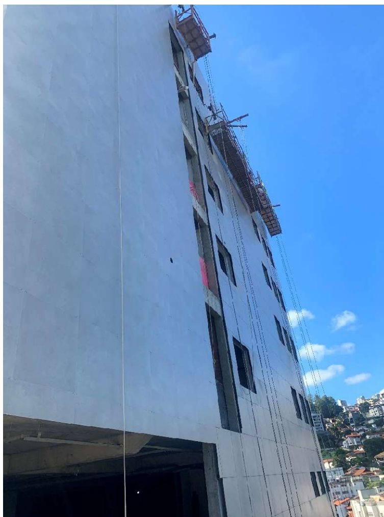
Figura 30: Pano de fachada finalizada
