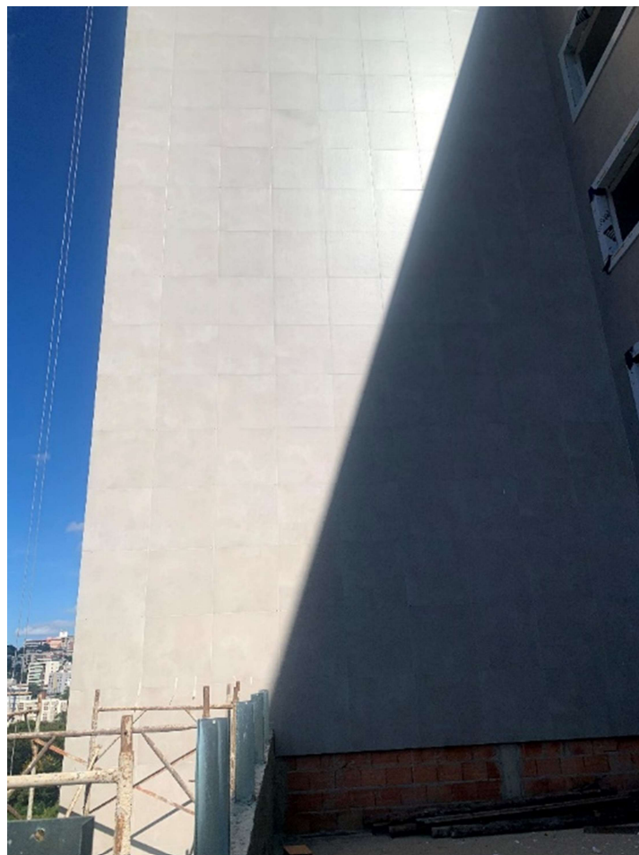
Figura 25: Pano de fachada finalizada
