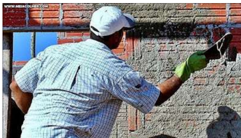
Figura 3: Aplicação do chapisco
