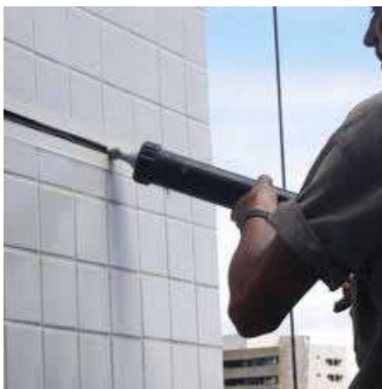
Figura 5: Execução de junta de dilatação
