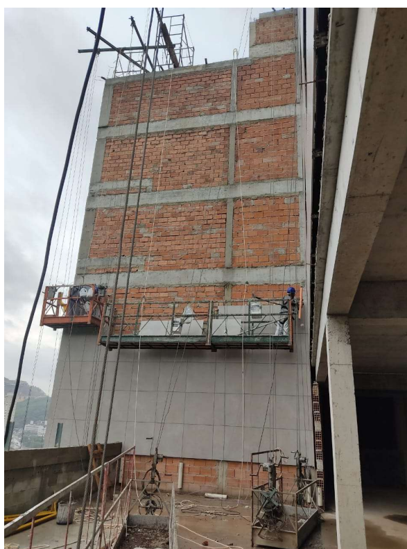
Figura 26: Execução da fachada ventilada
