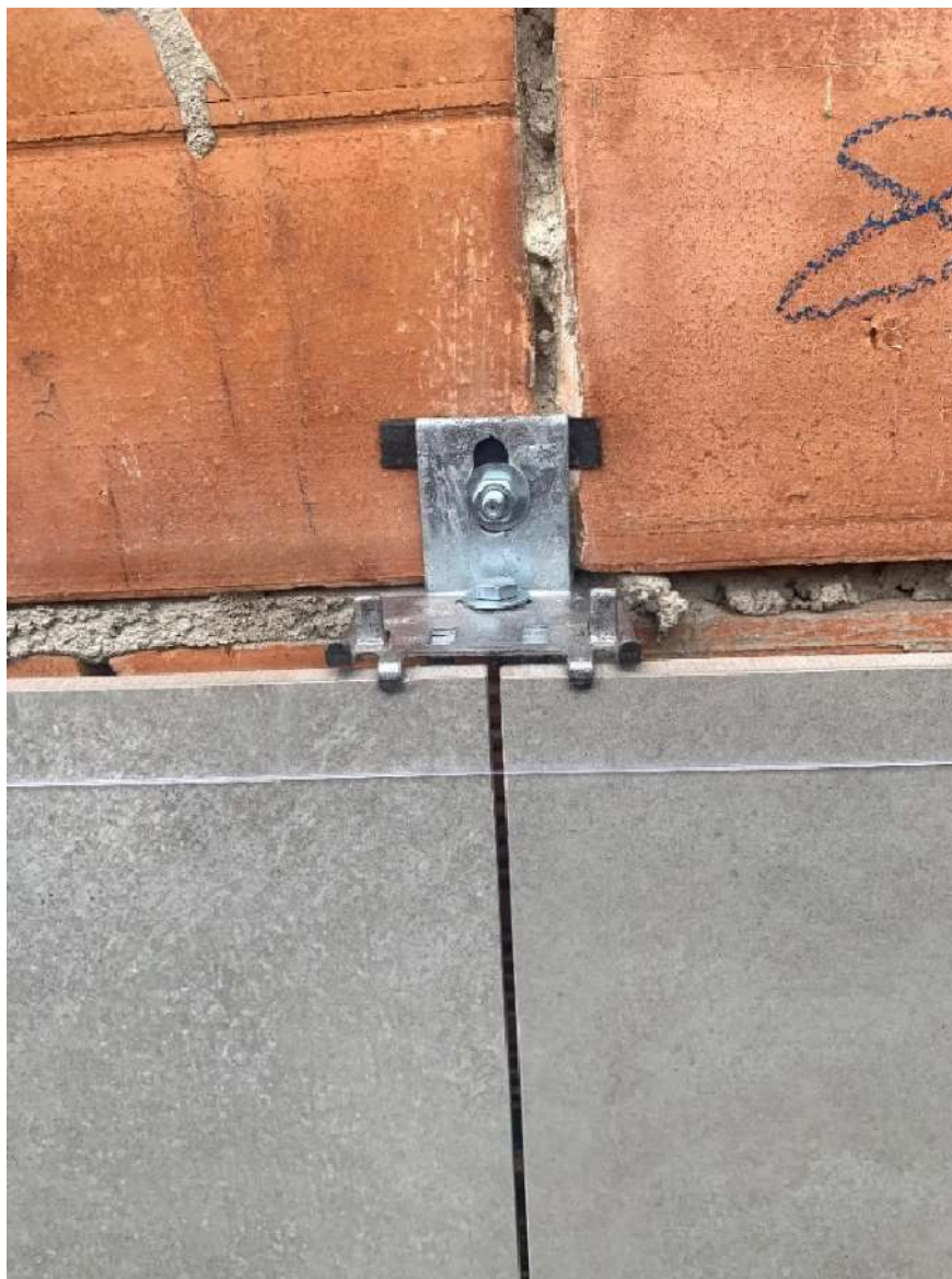
Figura 28: Insert metálico fixado na alvenaria
