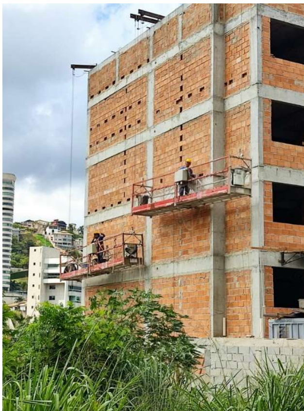
Figura 27: Execução de bolsão de concreto
