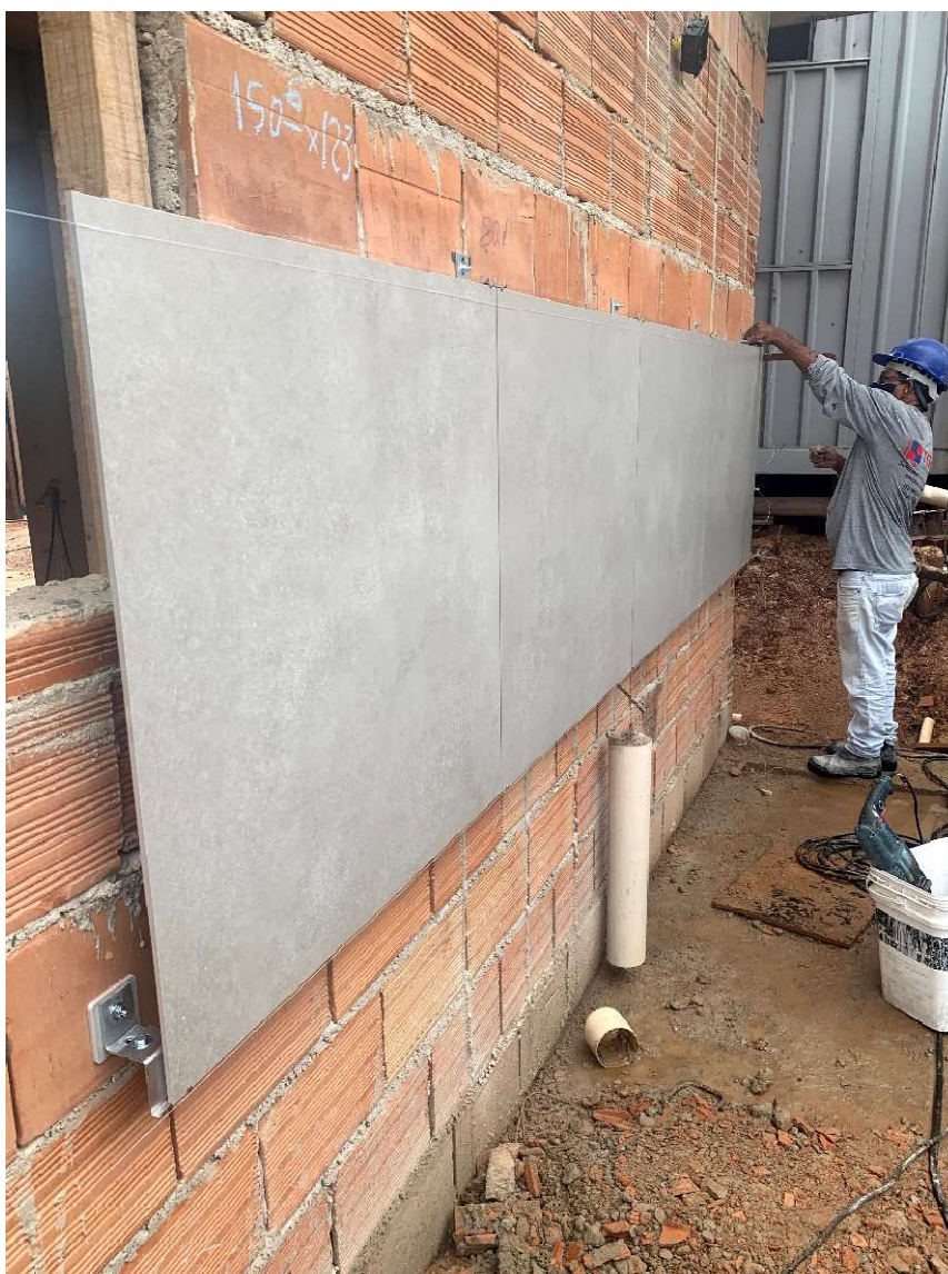
Figura 29: Execução da primeira fiada
