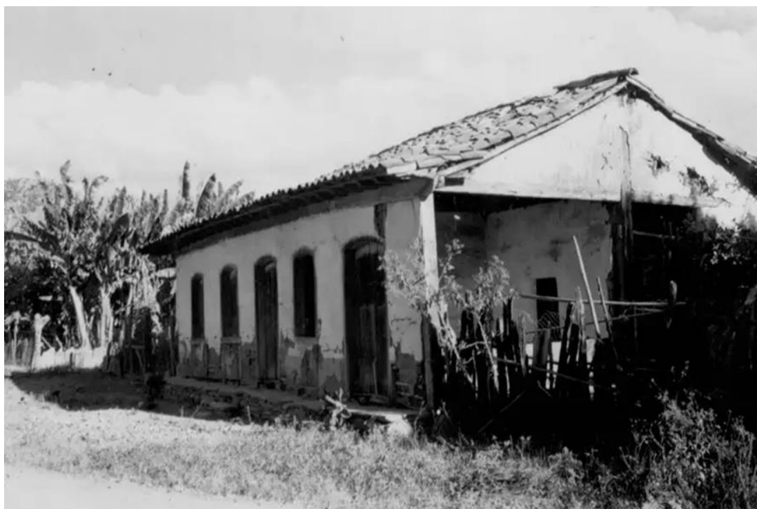
Figura 94: Casa da Quinta do Sumidouro no Distrito de Fidalgo em Pedro Leopoldo - MG.
