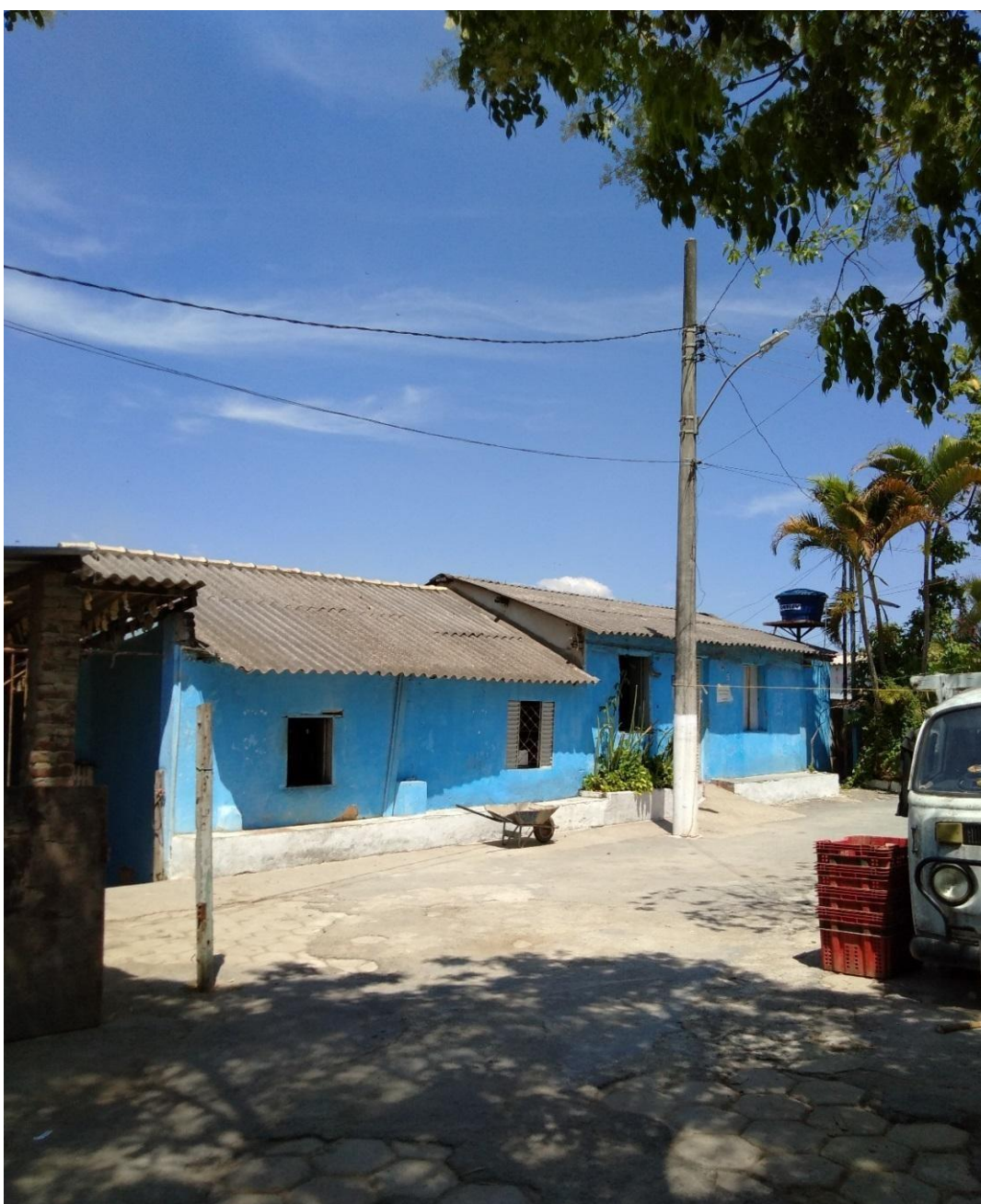
Figura 17: Fundo do vale com edificações comunitárias e de valor simbólico (casa inicial/patriarcal).
