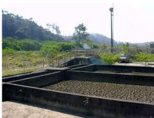
Figura 2.4 – Leitos de secagem de lodo
