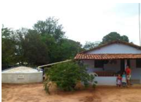
Figura 1: Cisterna de placas
