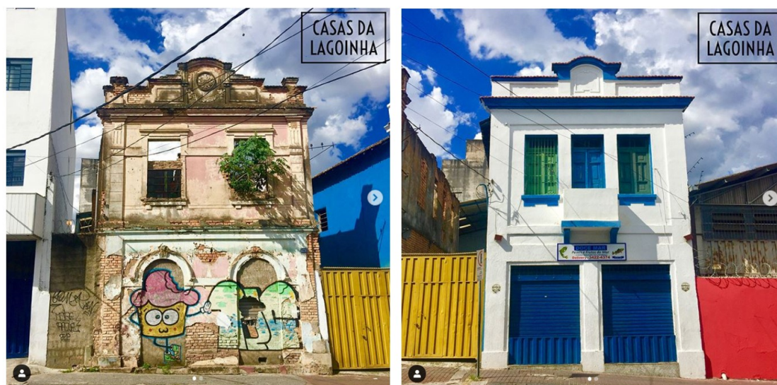
Figura 49 - Casas Tombadas na rua Bonfim nº 118 e 128
