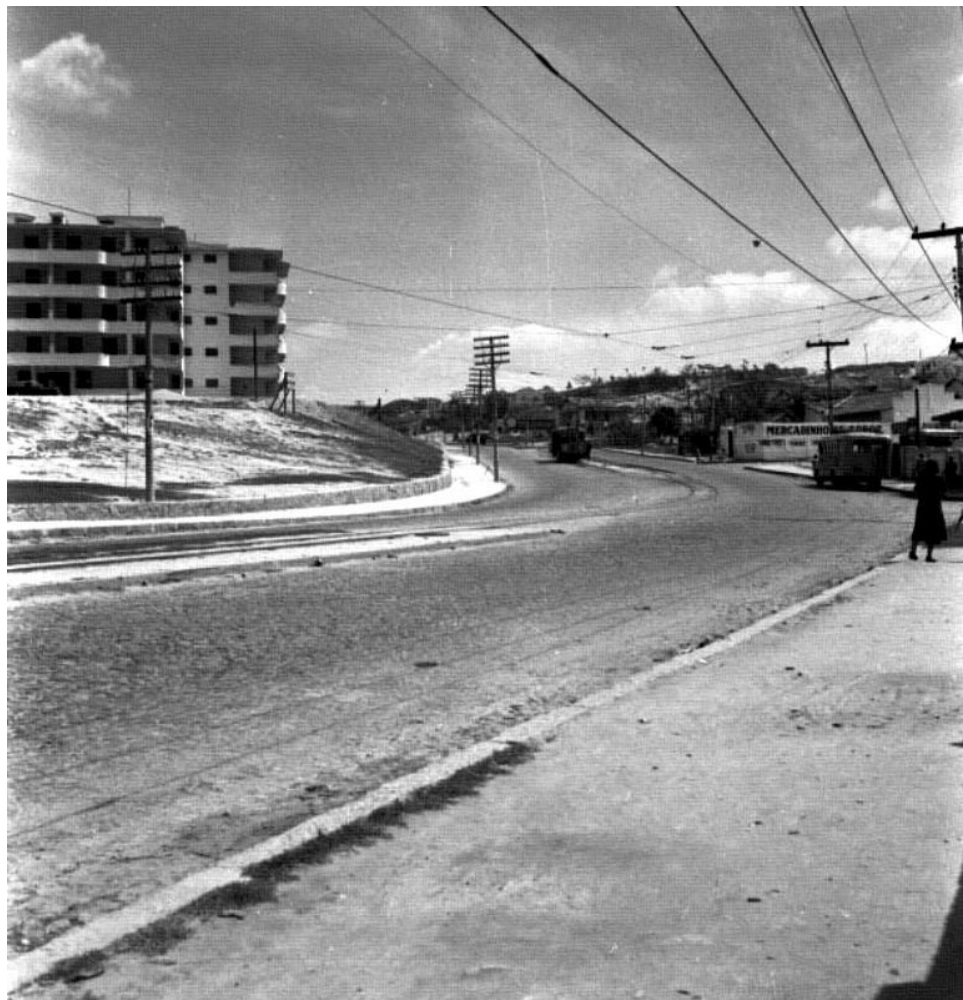
Figura 32 – Avenida Pampulha e Conjunto IAPI. Década de 1940
