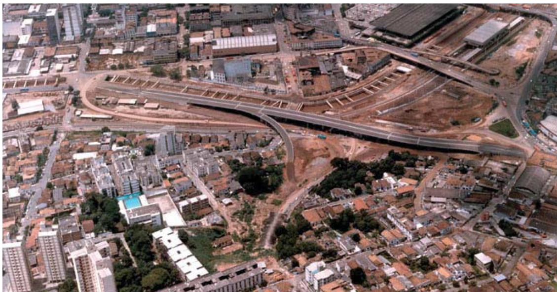
Figura 42 – Obras em andamento, 1984
