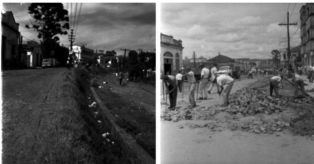
Figura 37 – Retirada dos trilhos da RMV. À esquerda na rua Mauá e à direita na praça Vaz de Melo
