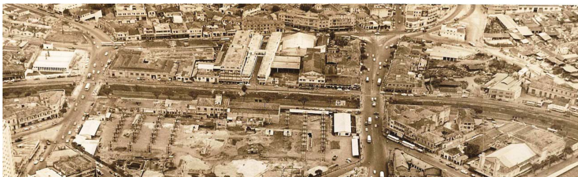
Figura 41 – Quarteirões demolidos para as obras do Trem Metropolitano e complexo viário
