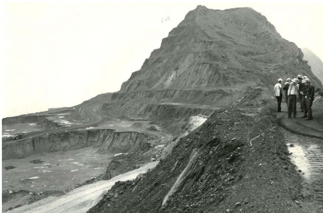
Figura 21 - Vista parcial da cava da MAC em meados de 1970
