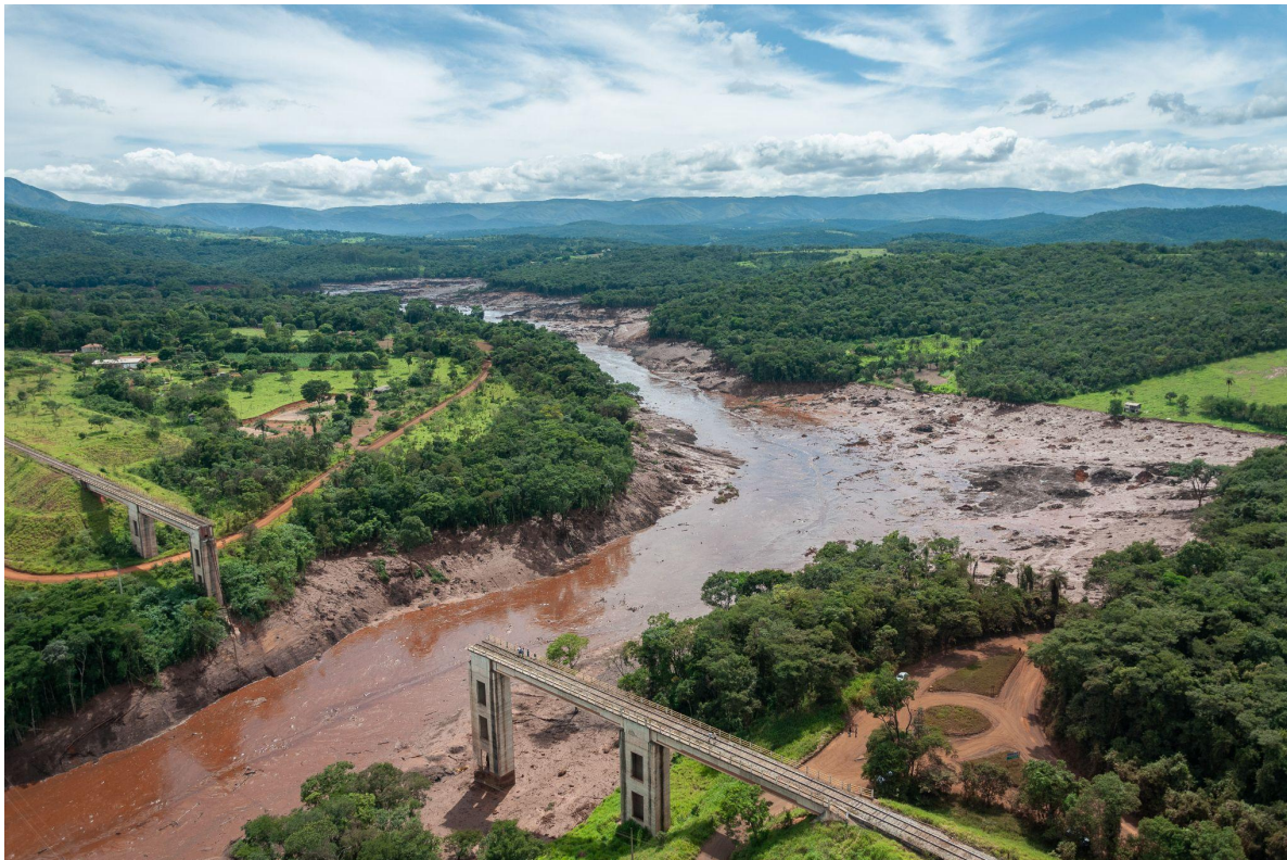
Fig. 4 - Imagem aérea sobre a Ponte na Rodovia Alberto Flores em Brumadinho-MG, destruída pela avalanche de lama ocasionada pelo rompimento da Mina Córrego do Feijão.
