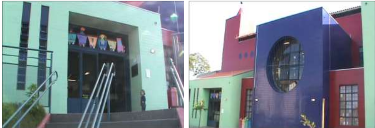
Figura 1 – Vista da parte da frente da EMEI
