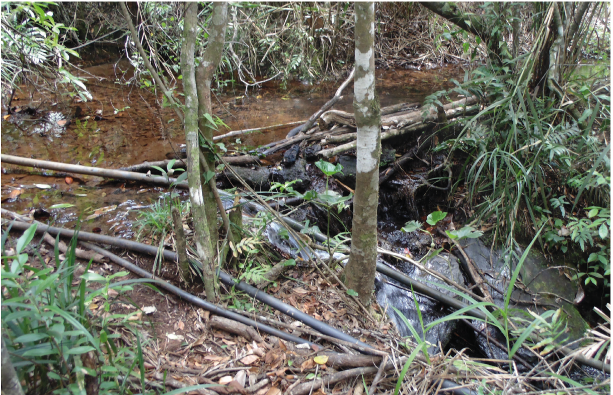
Figura 22 — Barramento feito de galhos e pedras. Mangueiras e dutos de adutoras
